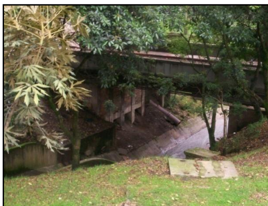
Figura 3.13. Río Arzobispo bajo el puente en concreto (Autor, 2011).
