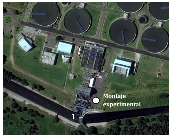
Figura 3.28 PTAR Salitre – Vista en planta de punto de muestreo (Google Earth v.6 y adaptado por Autor, 2012).
