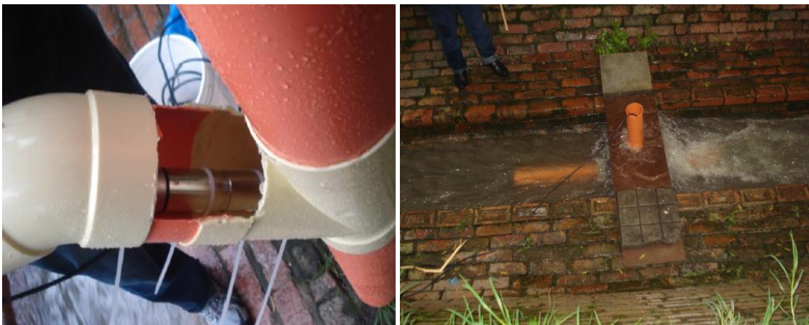
Figura 2.2 Instalaciones del turbidímetro en el Río Arzobispo, Bogotá (Alvarado, 2011)
