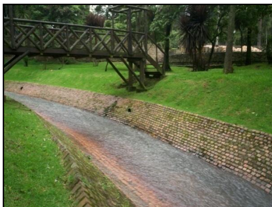
Figura 3.14 Río Arzobispo - Puente peatonal de madera (Autor, 2011).
