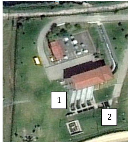
Figura 3.24 Estación elevadora de Gibraltar vista en planta (Google Earth v.6 y adaptado por Autor, 2012).
