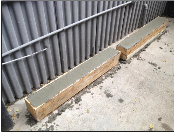
**Figura 34.** Resultado de las vigas de apoyo después de ser fundidas.
