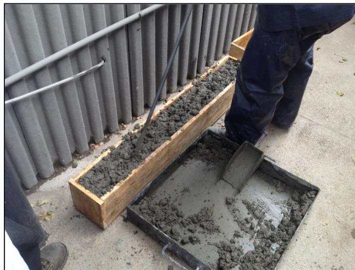
**Figura 33.** Vibrado del concreto de las vigas.
