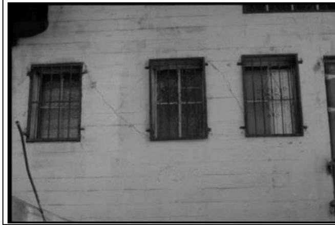
**Figura 7.** Grietas formadas por falla a corte (extraída de Giraldo y Mendez, 2006).
