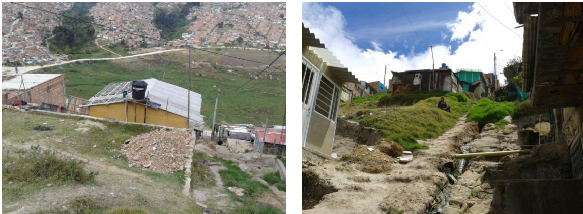
Figura 3.10: Ilustración pendientes elevadas y terreno erosionado
