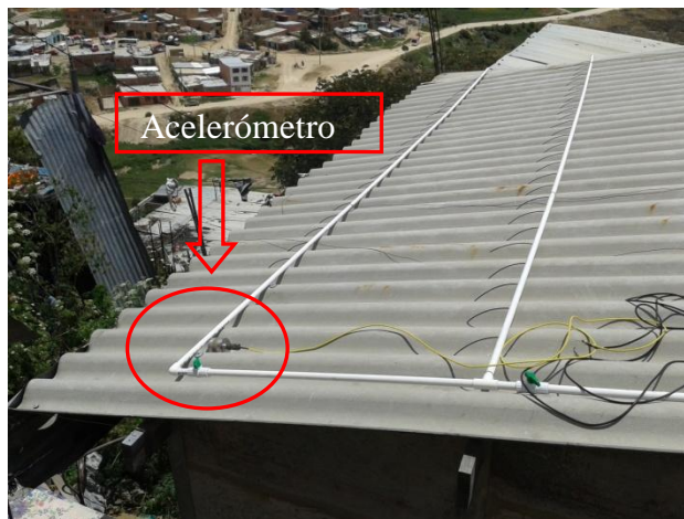
Figura 3.16: Ubicación acelerómetros. Vivienda sin Techo Verde. Vista: Perfil Fachada Norte
