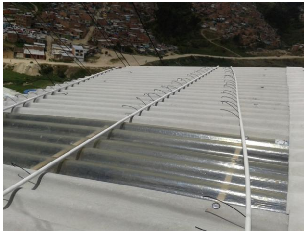
Figura 3.13: Sistema de riego por goteo
