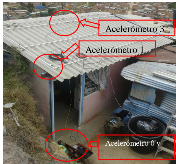
Figura 3.18: Ubicación acelerómetros. Vivienda Con Techo Verde. Vista: Perfil Fachada Norte
