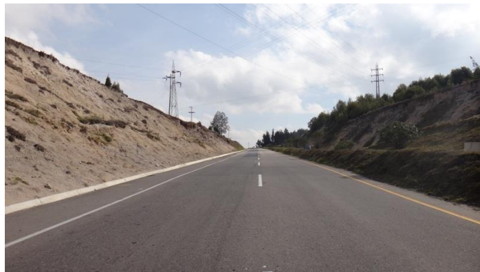
Fotografía 2. Taludes de corte sobre vía de la Concesión BTS
