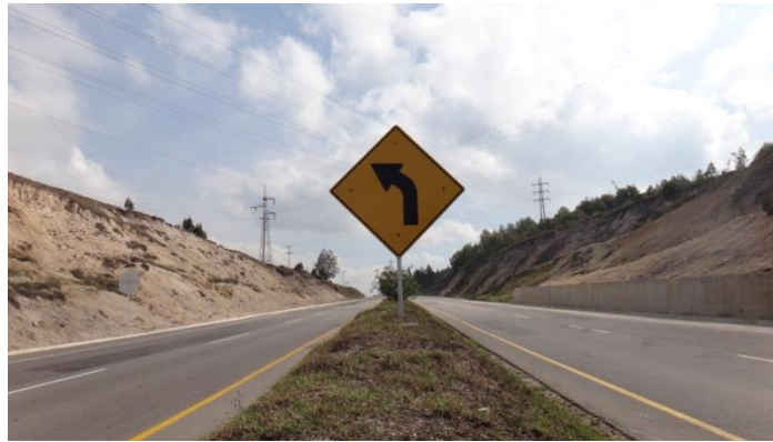
Fotografía 1. Vía Tunja- Sogamoso, Concesión BTS
