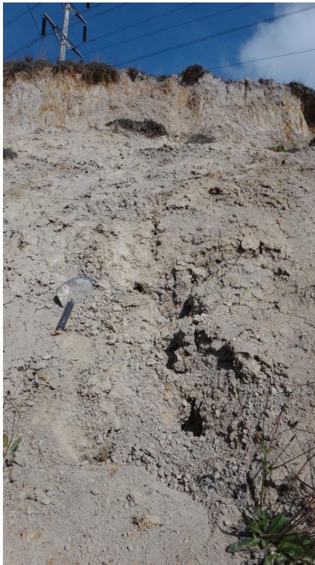
Fotografía 7. Vista frontal del talud
