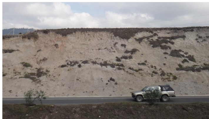
Fotografía 3. Talud de la vía seleccionado
