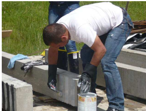
Figura 25: Aplicación del adhesivo epóxico
