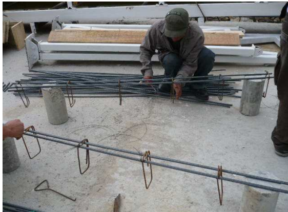
Figura 21: Armado de refuerzo interno de vigas
