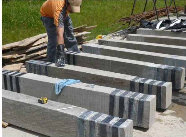
Figura 26: Preparación de la superficie
