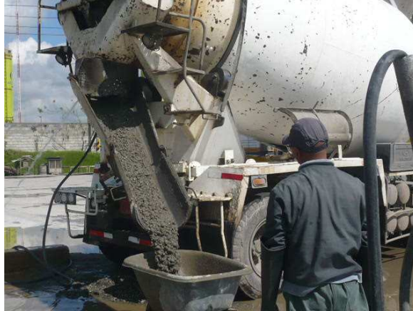
Figura 23: Concreto premezclado para construcción de vigas
