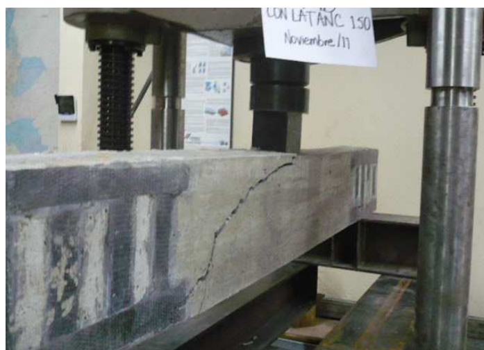
Figura 51: Viga 5B después de falla
