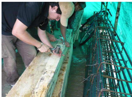
Figura 22: Elaboración de formaletas de madera
