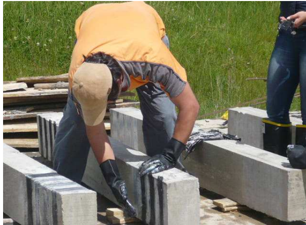
Figura 27: Colocación de tiras de CFRP
