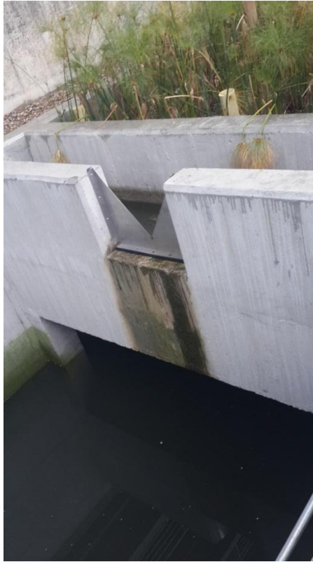
Ilustración 12. Vertedero Triangular ubicado a la salida del Humedal-Construido/Tanque regulador Fuente: Autor.
