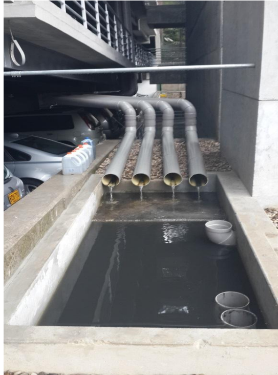
Ilustración 11. Afluente correspondiente a la cuenca aferente al edificio de parqueaderos. Fuente: Autor
