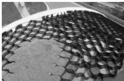
**Figura 2. Sistema de mallas para techos inclinados.**
