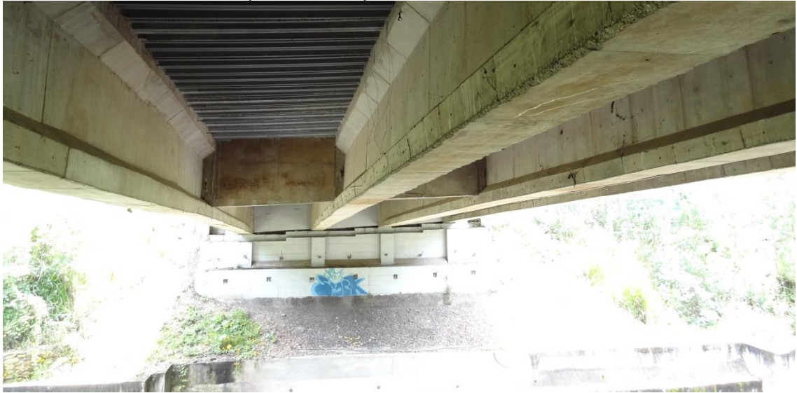
Foto 6-2 Foto de súper estructura puente los gaviones
