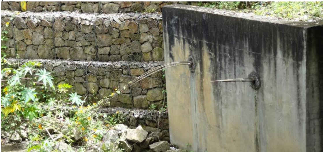
Foto 6-3 Protección con gaviones y muros con anclajes
