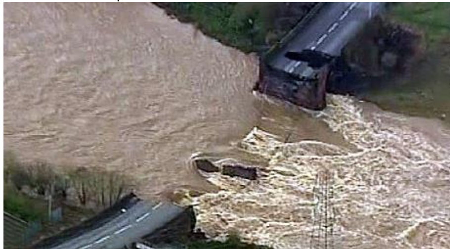
Foto 2-6 Colapso del puente sobre el río Derwent Cumbria. Fuente: (BBC News, 2009)
