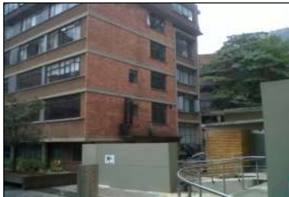
Figura 4. 2- Edificio Carlos Ortiz
