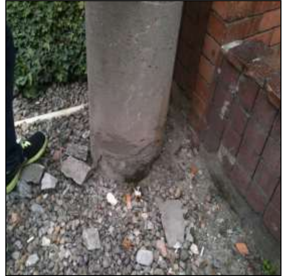
Figura 2.12 - Recubrimiento en mortero pobre de columna perimetral del edificio Carlos Ortiz S.J. [52]
