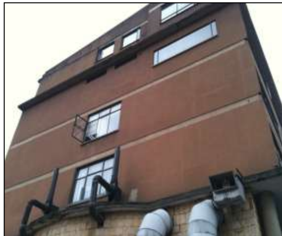
Figura 2.10 - Fachada norte del edificio Carlos Ortiz S.J. [52]
