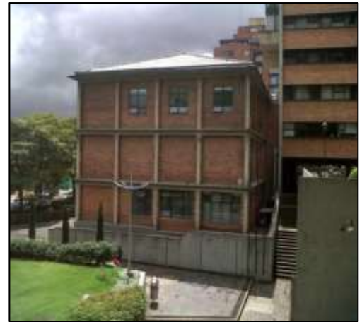
Figura 4. 4– Edificio Félix Restrepo.
