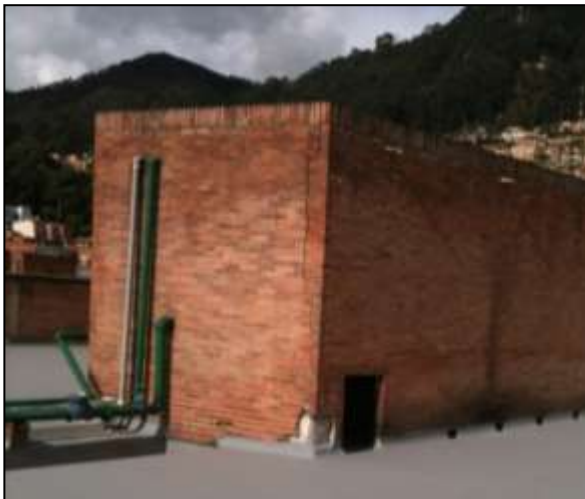
Figura 2.7 - Tanque en la parte superior del edificio Ángel Valtierra S.J. [51]
