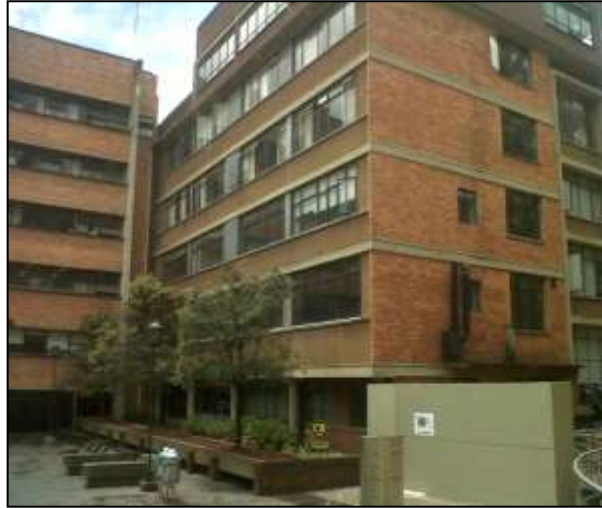
Figura 2.9 - Fachada sur del edificio Carlos Ortiz S.J. [52].
