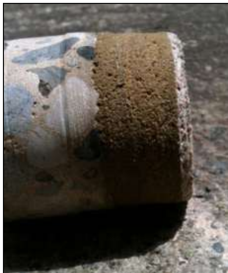
Figura 5.1 2– Recubrimiento de 3 cm de mortero en las columnas exteriores del edificio Carlos Ortiz, S.J. [52].
