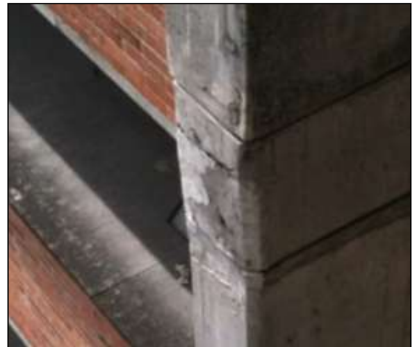
Figura 2.8 - Nudo del quinto piso del edificio Ángel Valtierra S.J. [51]
