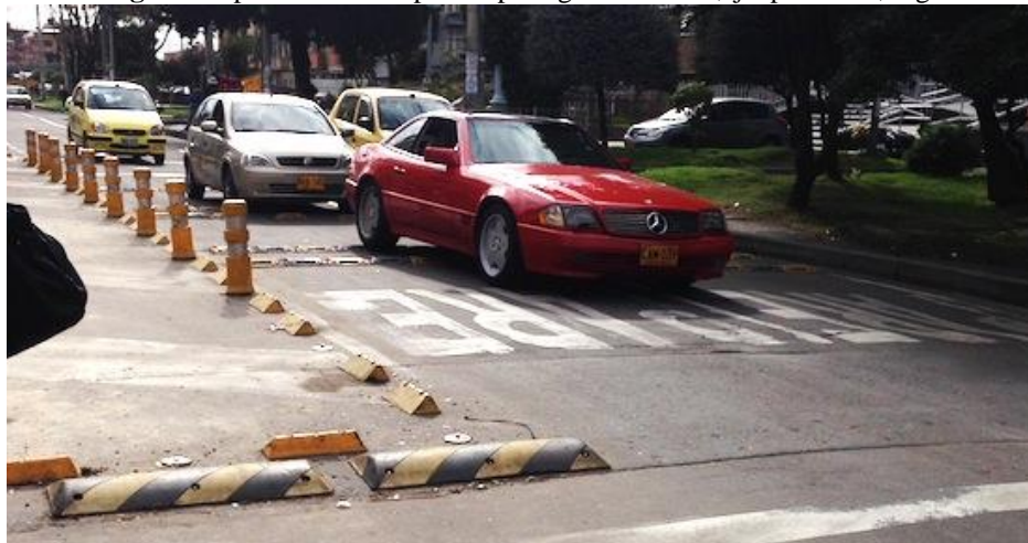
Imagen 35. Implementación de dispositivos para regular la velocidad, ejemplo Galerías, Bogotá.
