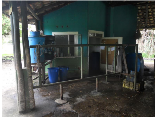
Ilustración 9: Instalaciones de la sala de ordeño – Fuente: Autor
