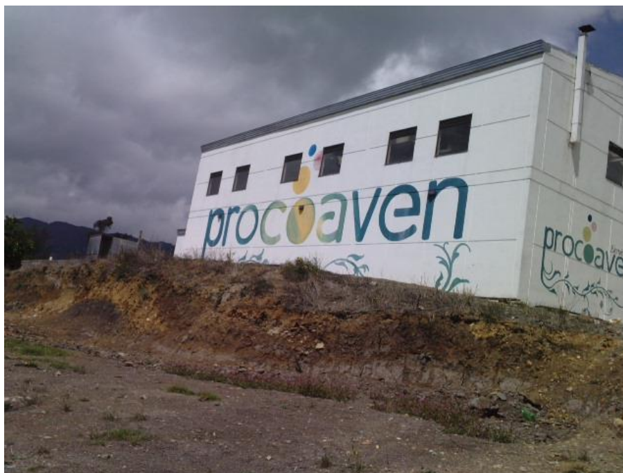
Imagen 7. Centro de Acopio Procoaven
