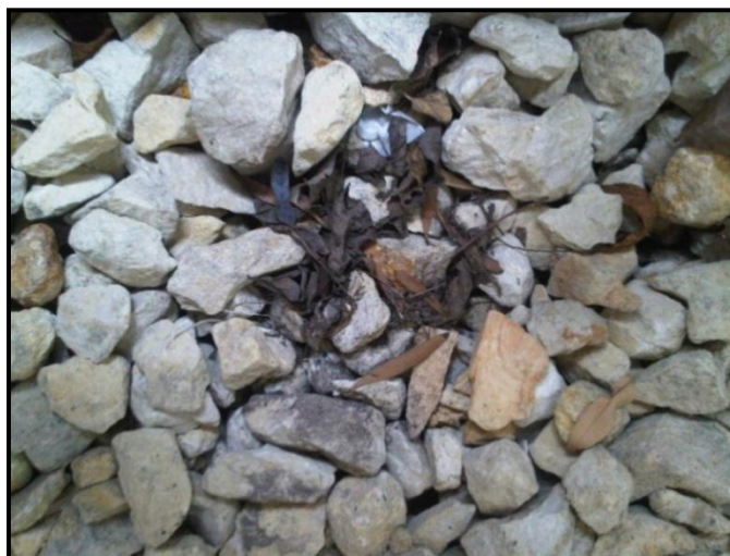
Figura 4 - 31 Retención de material orgánico en la entrada de la trinchera.
