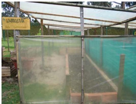
**Foto No.7 Infraestructura del lombricultivo en ladrillo y con techo de plástico.**
