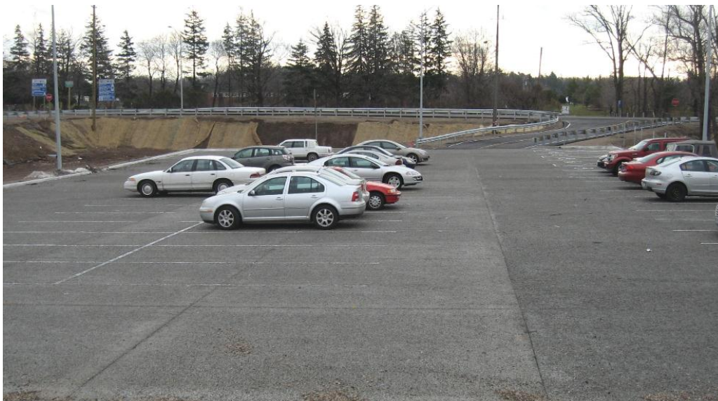
Imagen 34. Pavimento permeable en asfalto poroso en Ontario Canadá (Fuente: Ministerio de Transporte de Ontario: http://www.mto.gov.on.ca/english/transtek/roadtalk/rt15-2/ )
