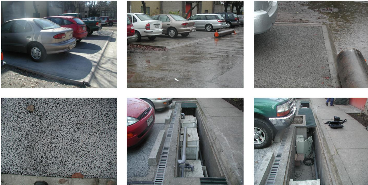
Imagen 39. Aplicación de pavimentos en concreto poroso para estacionamientos en el Campus San Joaquín de la Universidad Católica de Chile (Fuente: Centro de Aguas Urbanas: http://www.centroaguasurbanas.cl/docimágenes-piloto.htm )
