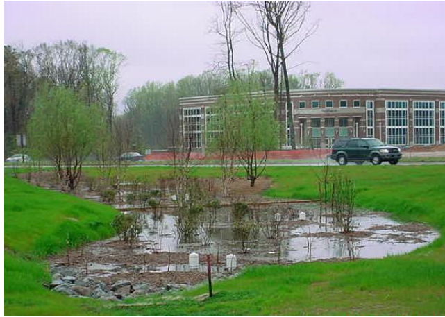
Imagen 6. Área de bioretencion (Fuente: PRIDE: http://www.protectedwithpride.org/images/newimagesgifsagust0104/BIO.2.JPG )
