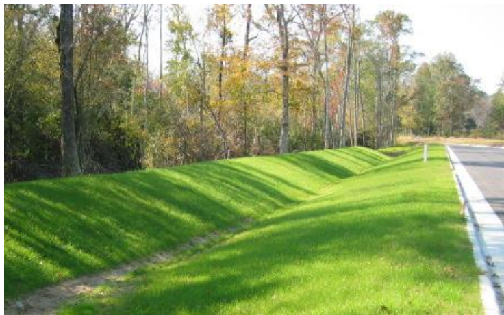
Imagen 5. Canal vegetado: (Fuente: Thomas Engineering PA: http://www.thomasengineeringpa.com/images/Swale%202.JPG )
