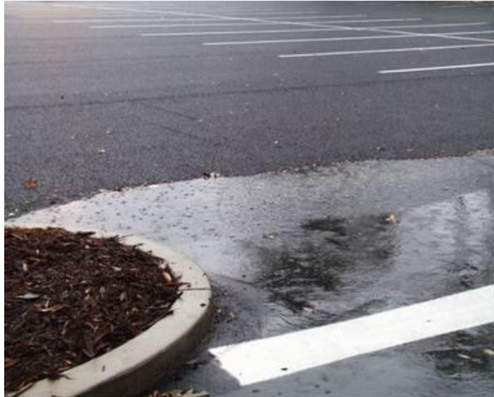
Imagen 35. Contraste entre Pavimento permeable en asfalto poroso al fondo de la imagen, y pavimento convencional al frente, en la Universidad de Carolina del Norte, USA (Fuente: Green Counsel: http://nylawline.typepad.com/greencounsel/2006/09/they_paved_para_1.html ).
