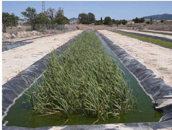
Imagen 15. Humedal artificial (Fuente: Madri+d noticias: http://www.madrimasd.org/gestion2006/img/Noticias/analisis220306Fig3.jpg )
