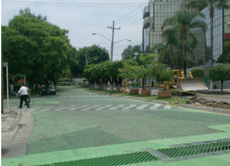
Imagen 33. Pavimento permeable en asfalto poroso frente al hotel Intercontinental de Zapopan, Jalisco (México) (Fuente: Eco Concreto: http://www.ecologiaenconcreto.com.mx/aclaraciones.pdf )
