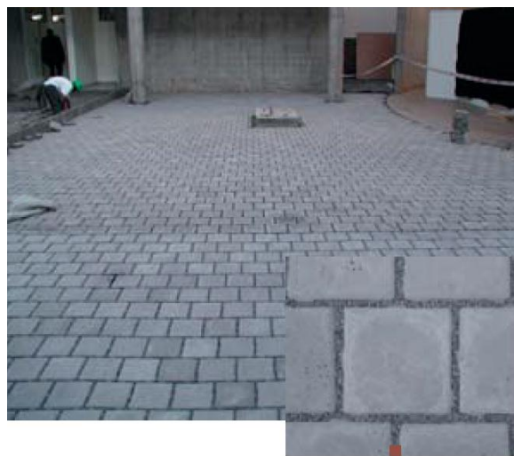
Imagen 40. Aplicación de pavimento permeable en adoquines de concreto poroso en el Centro de Eventos y Convenciones Espacio Riesco en Santiago de Chile (Fuente: Centro de Aguas Urbanas: http://www.centroaguasurbanas.cl/documentos/Uso_de_Pavimentos_Permearbles_Revista_BIT.pdf )
