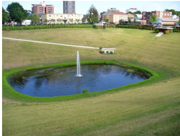
Imagen 13. Cuenca de detención (Fuente: Wikipedia: http://upload.wikimedia.org/wikipedia/en/4/47/Boneyard_Detention_Basin.jpg )
