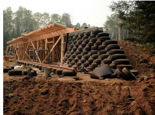
(d) - Muros (Earthships: construcción con neumáticos y tierra, 2011)
