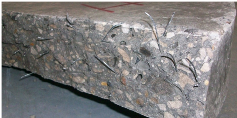
Ilustración 44 – Estado final de las fibras metálicas, luego de ensayo de placa circular (Nótese la pérdida del anclaje en los extremos)
