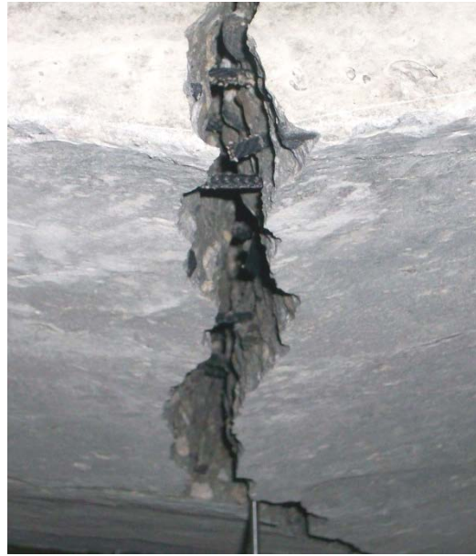
Ilustración 43 – Falla típica de placa circular de concreto adiccionado con caucho
