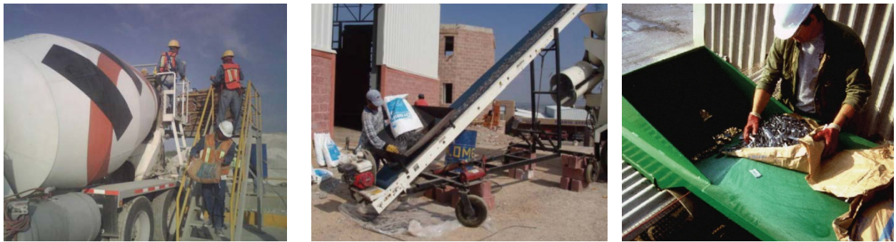
Ilustración 9 – Adición manual de fibras (Cardona, 2010)
