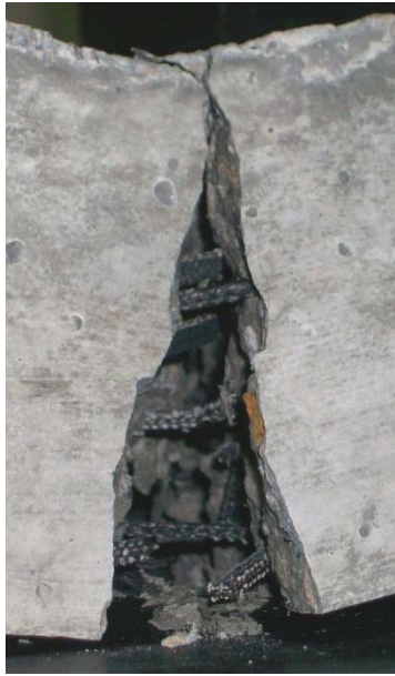
Ilustración 42 – Falla típica de placa cuadrada de concreto adiccionado con caucho
