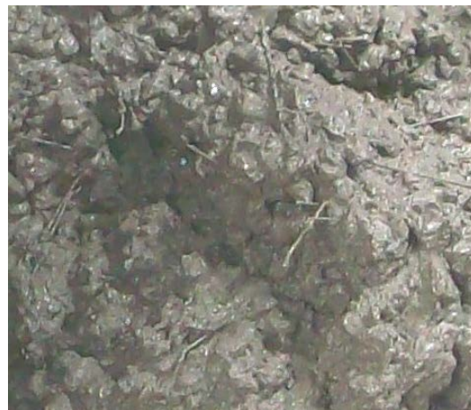
Ilustración 26 – Concreto adicionado con fibras metálicas
