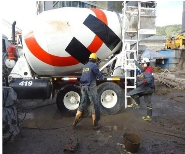
Figura 4. Lavado de llantas de mezcladoras de concreto(Promotora Apotema & Coordinación LEED 2011)
