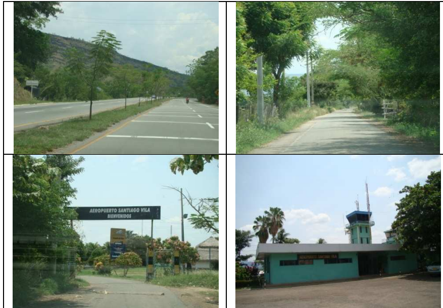
Figura 15. Estado actual de las vías de acceso al aeropuerto Santiago Vila
