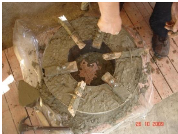
Imagen 5.5: Anillo fundido en obra.
