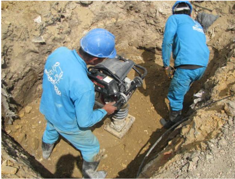
Imagen 8.7: Ayudantes realizando proceso de compactación y nivelación de la cota de trabajo.
