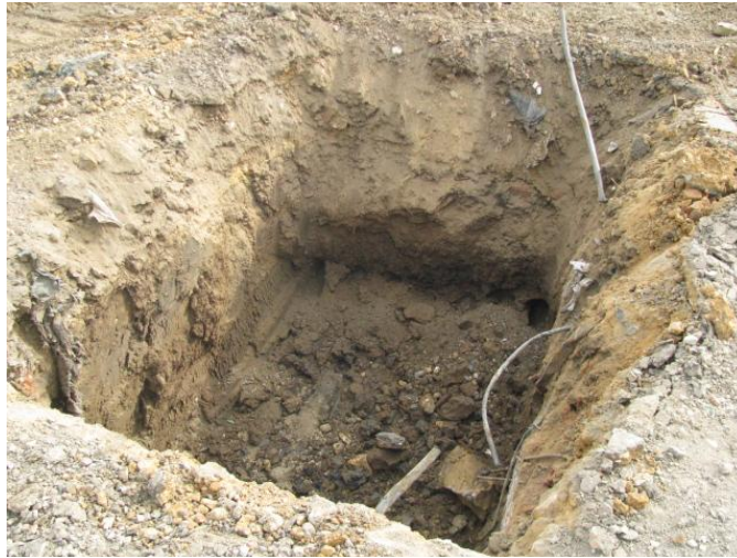
Imagen 8.5: Excavación mecánica realizada por la retroexcavadora.
