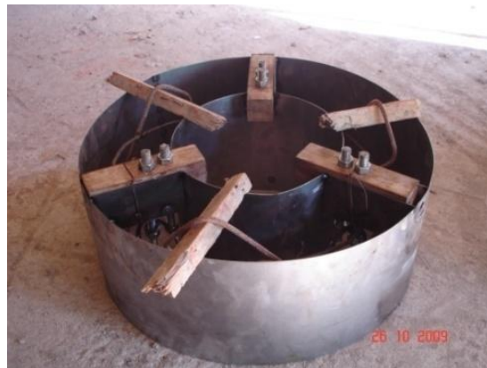
Imagen 5.4: Anillo con refuerzo y varillas roscadas previo a la fundida.
