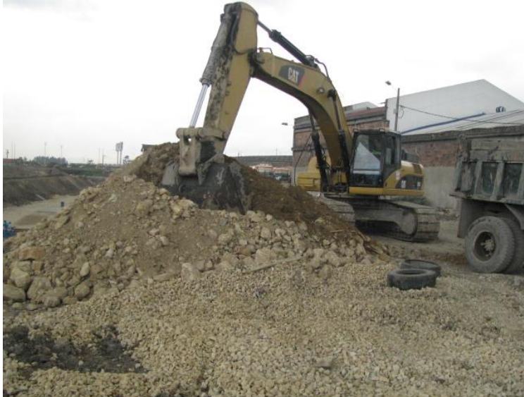
Imagen 8.4: Retroexcavadora cargando volqueta con material de trabajo.
