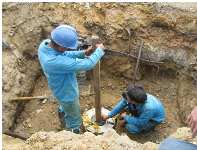
Imagen 8.6: Ayudantes rectificando la profundidad de trabajo.
