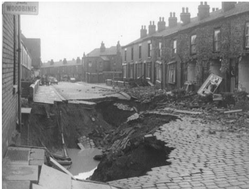
Figura 2.1: Colapso de sistema de alcantarillado, calle Fylde, Fernworth, Lancashire, Gran Bretaña (Bolton History Centre, 1957).
