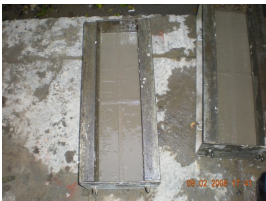
Foto 9. Viguetas fundidas
