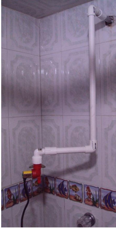
Imagen 4. Instalación de la electroválvula en la ducha
