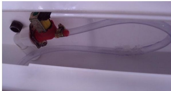
Imagen 11. Ensamble de la válvula dentro del tanque
