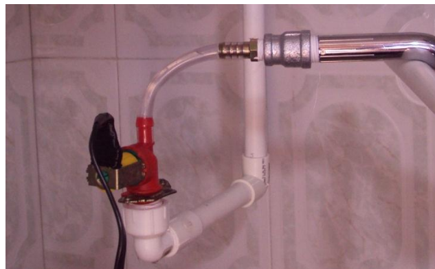
Imagen 6. Instalación del montaje interno del tanque EcoRain
