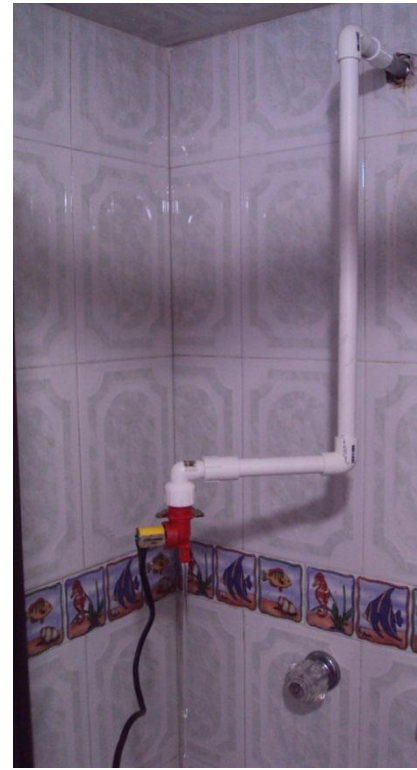
Imagen 5. Instalación de la electroválvula en funcionamiento
