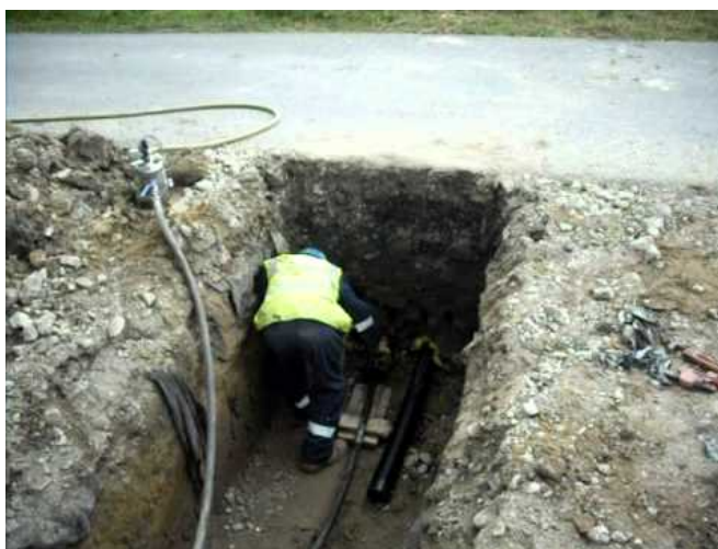
Imagen N°10: Pozo Impact Moling (WordDomination, 2014)
