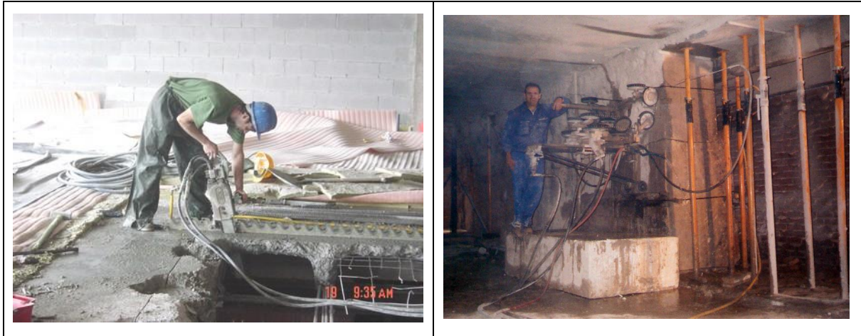
Figura 9. Demolición corte diamante. Fuente: (AEDT, 2013)
