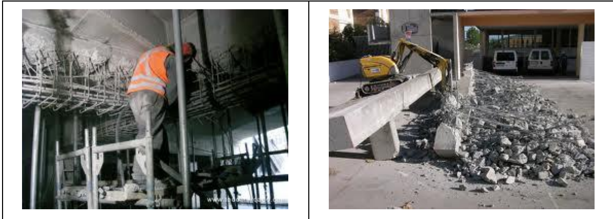
Figura 4. Demolición selectiva. Fuente: Cordesa (2012)
