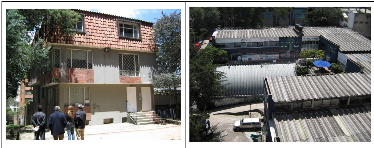
Figura 13. Casa Coral, Edificio No. 4 y Hangar. Fuente: Restrepo y Uribe S.A.S, 2014.
