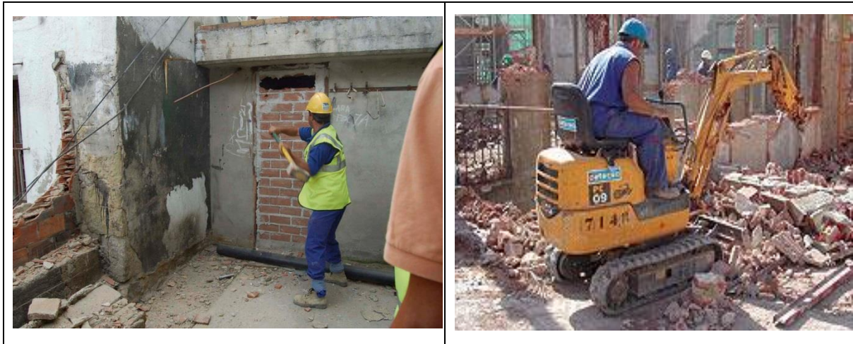
Figura 6. Demolición manual. Fuente: (Construcciones Triguero, 2012)
