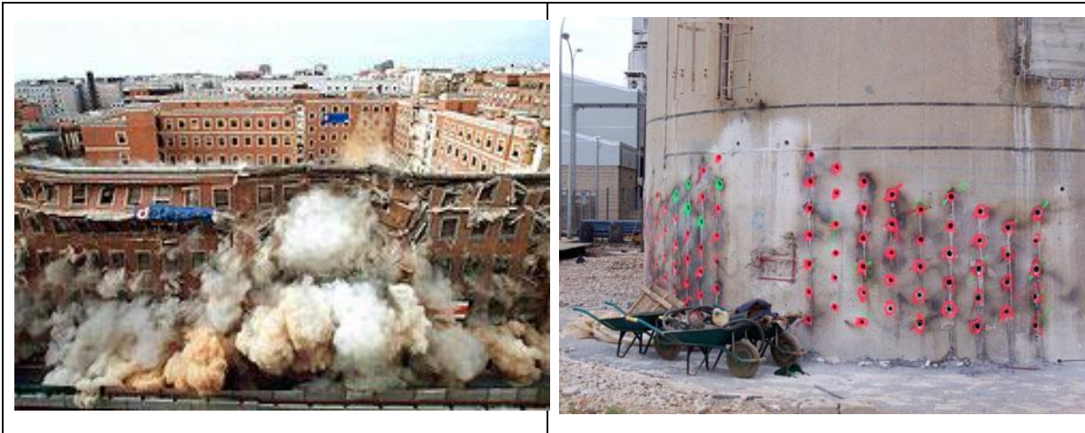
Figura 5. Demolición por voladura. Fuente: (Detecsa, 2013)
