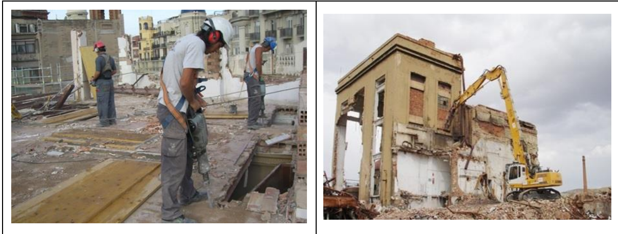
Figura 3. Demolición convencional. Fuente: Aeded (2012), (Cordesa, 2012)
