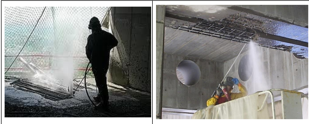
Figura 7. Hidrodemolición. Fuente: (GEORA Aplicaciones Técnicas, 2013)
