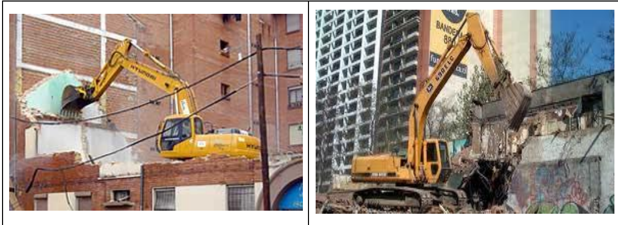
Figura 8. Demolición mecánica. Fuente: (Demoliciones Hernan Meza, 2013)
