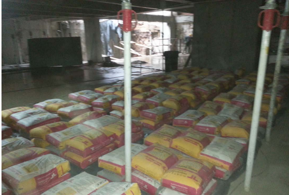
Ilustración 6.22 Aplicación de la carga viva mediante bultos de mortero.
