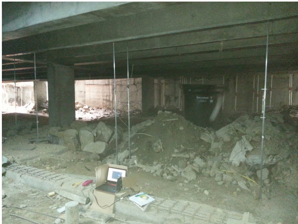
Ilustración 6.23 Equipo utilizado en la prueba de carga
