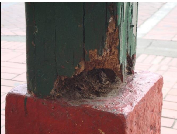
Figura 7 - Descomposición de la madera (Uribe et al., 2013)
