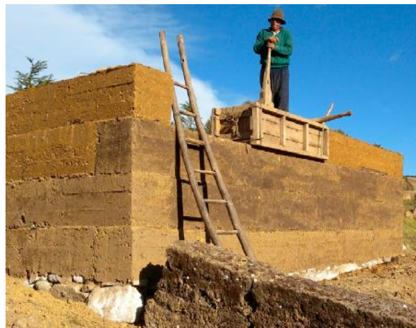
Figura 9 - Proceso constructivo de la tapia pisada (Chang et al., 2013)
