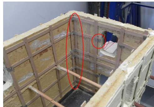
Figura 54 - Unión entre esquinas, puertas y ventanas
