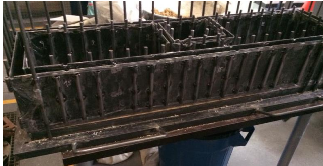
Figura 46 - Formaleta armada del primer piso
