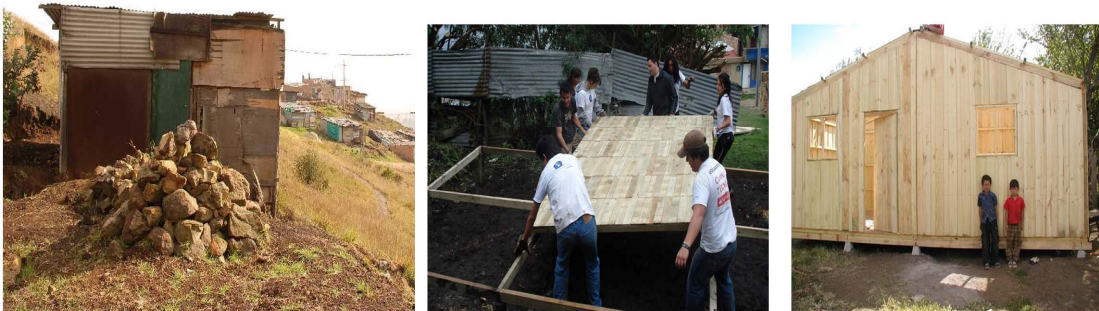
Gráfico No 2. Proceso de construcción de la vivienda de madera. Diseñado por las autoras, 2008.
