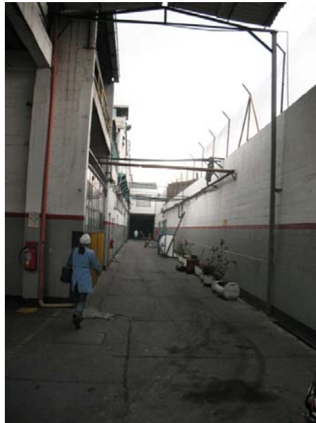
Instalaciones Eterna S.A. Zona Industrial Fuente: Autor (2007)
