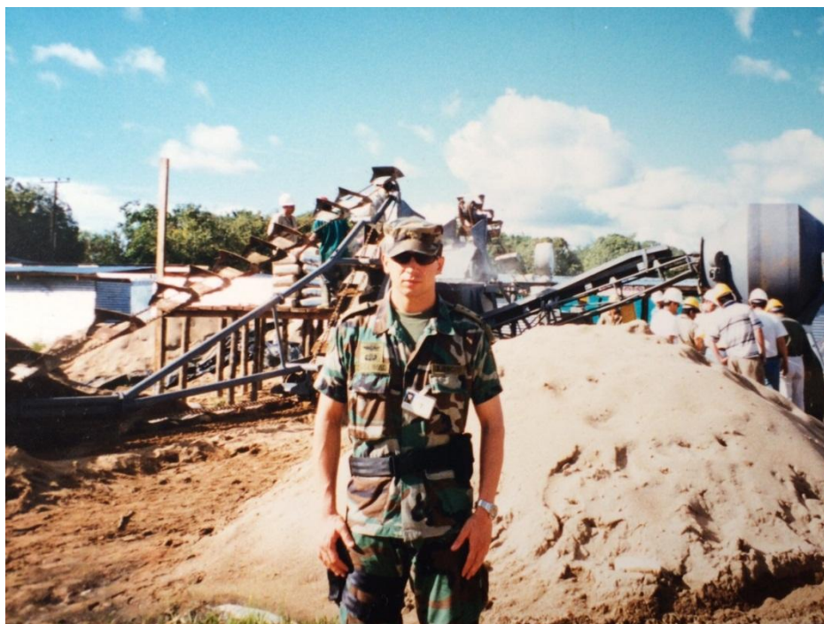
Fotografía No. 3: Ing., Héctor Mario Garcia, Base Tres Esquinas – Caquetá, 2002, El Autor frente a la Planta de Concreto Móvil instalada para ejecutar las obras.
