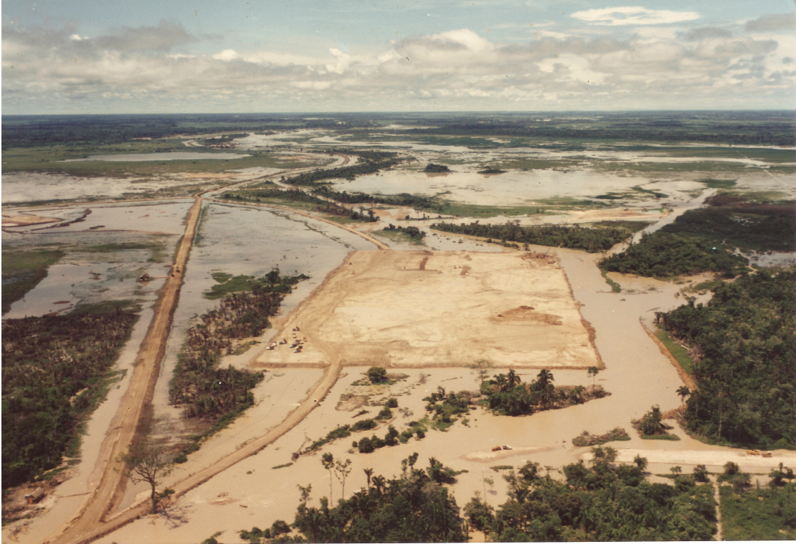
Fotografía: Jorge Navea. Construcción de Caño Limón. 1983 (aproximadamente)
