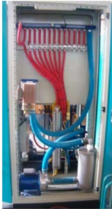
**Sistema de refrigeración del convertidor**
