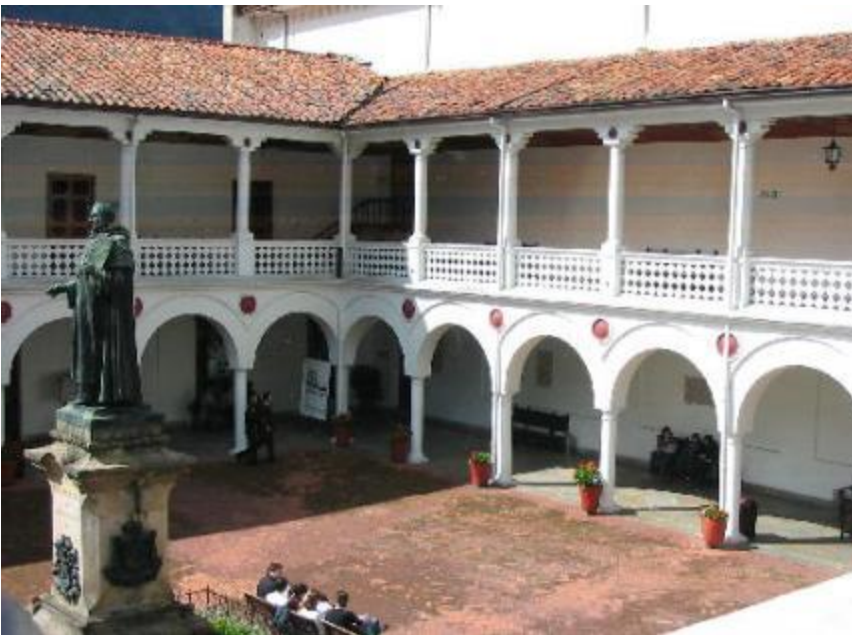
Fotografía del estado actual del Claustro.
