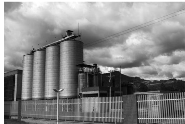
Contaminación por uso de tecnologías deficientes.
