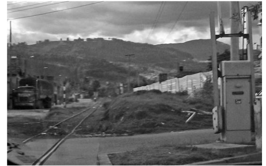
Infraestructuras férreas subutilizadas
