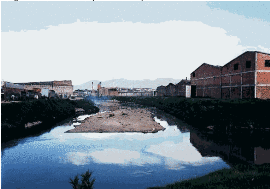
Imagen 3: Construcciones que le dan la espalda al río.
