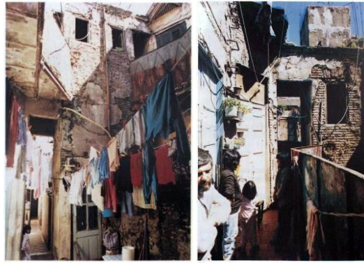
Imagen N° 32, 33: Vista interior de las casas de patio de la Calle Moreno (Junta de Andalucía, Consejería de Obras Públicas y Transporte. Rehabilitación Manzana de San Francisco. Proyecto y Gestión ).
