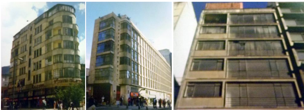
Imagen N° 2, 3, 4: (de izq a der) Edificio Camacho Matiz, Edificio Sociedad de Agricultores y Edificio Martín Gómez. (Carlos Niño Murcia/Sandra Reina Mendoza. La carrera de la modernidad: construcción de la Carrera Décima. Bogotá [1945-1960] . Pág 177, 180, 188 respectivamente).
