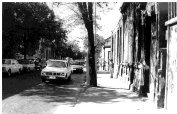
Imagen N°42: Deterioro en Área Central de Santiago de Chile. En: “Programa de repoblamiento comuna de Santiago: un programa de gestión urbana” . Pág 54.
