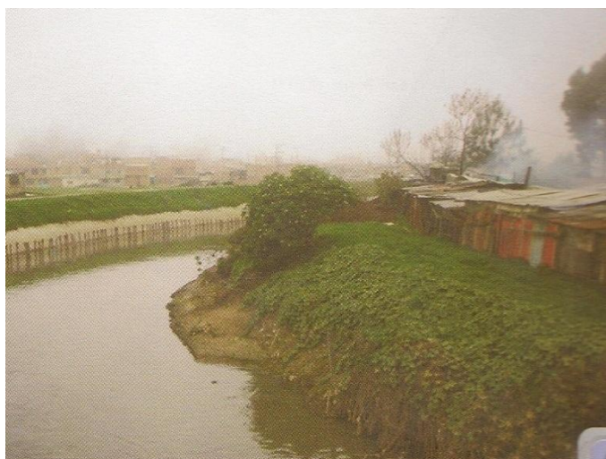
Imagen No.15. Inundaciones y deslizamientos.
