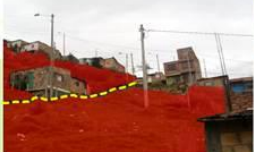
Espacios vacíos que no han sido ocupados por la inclinación del terreno y el peligro por deslizamientos
