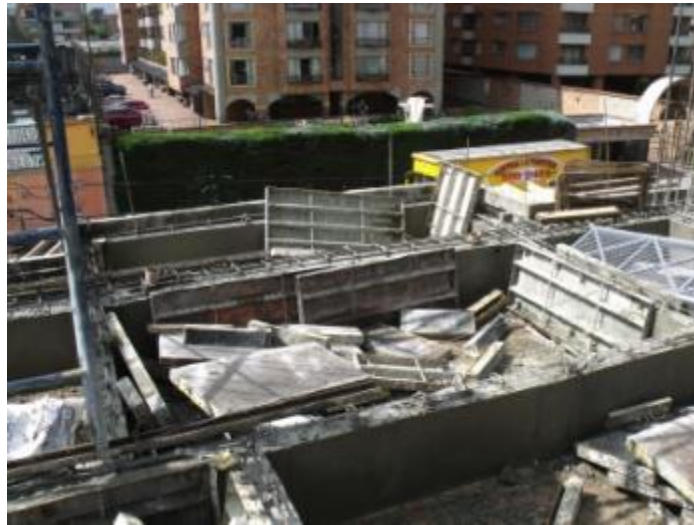
Figura 48. Retiro de formaleta. Fecha de toma: 05-NOV-11
