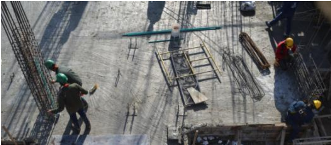
Figura 63. Fotografía 11-FEB-12. Sección de Fotografía de Armado de Columnas
