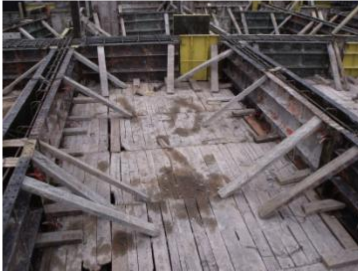
Figura 42. Puntales en madera para sostener formaleta. Fecha de toma: 05-NOV-11
