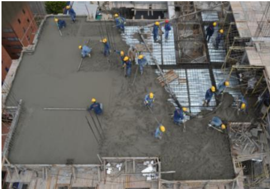
Figura 75. Fotografía 20-FEB-12. Sección de Fotografía Disposición malla y vaciado recubrimiento
