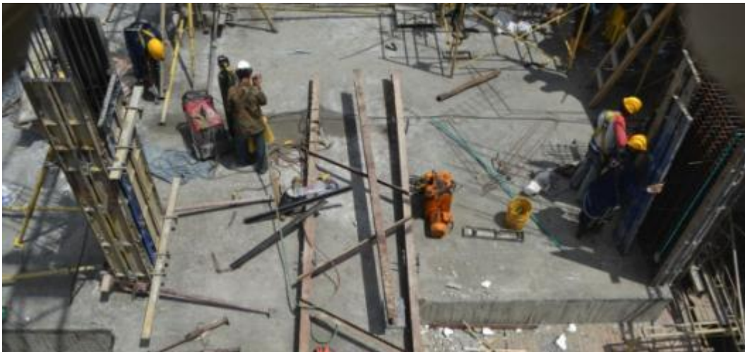
Figura 65. Fotografía 11-FEB-12. Sección de Fotografía Armado Formaletas Columnas
