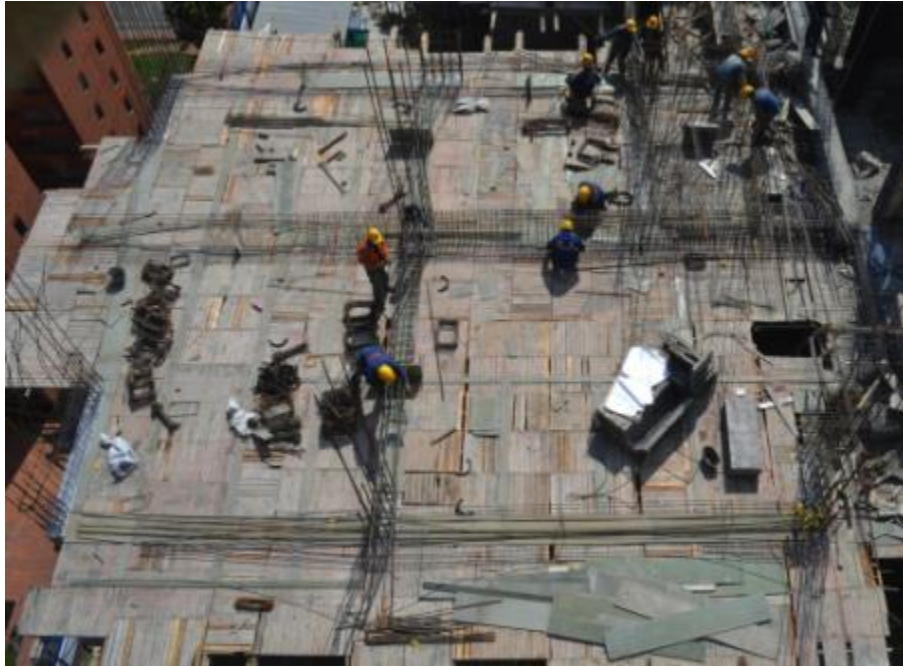
Figura 70. Fotografías 17-FEB-12. Sección de Fotografía amarre de Vigas
