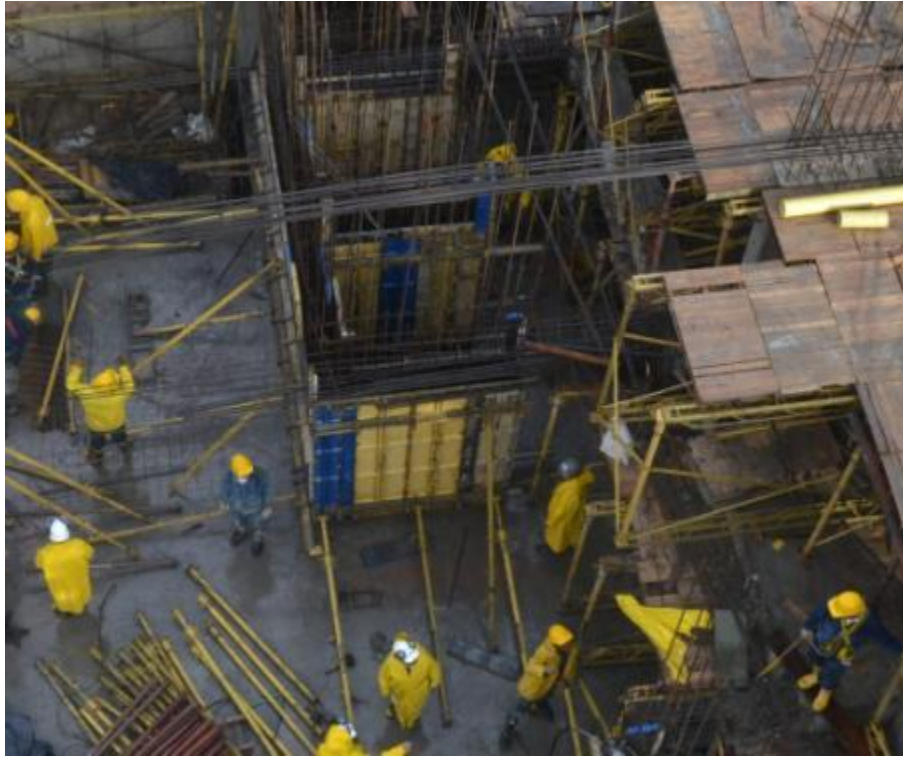
Figura 66. Fotografía 09-NOV-11. Sección de Fotografía concreto columnas
