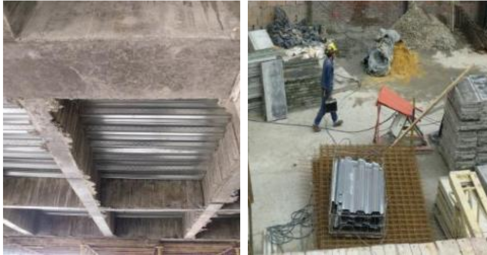
Figura 35 y 36. Disposición y corte de metaldeck. Fecha de Toma: 05-NOV-11
