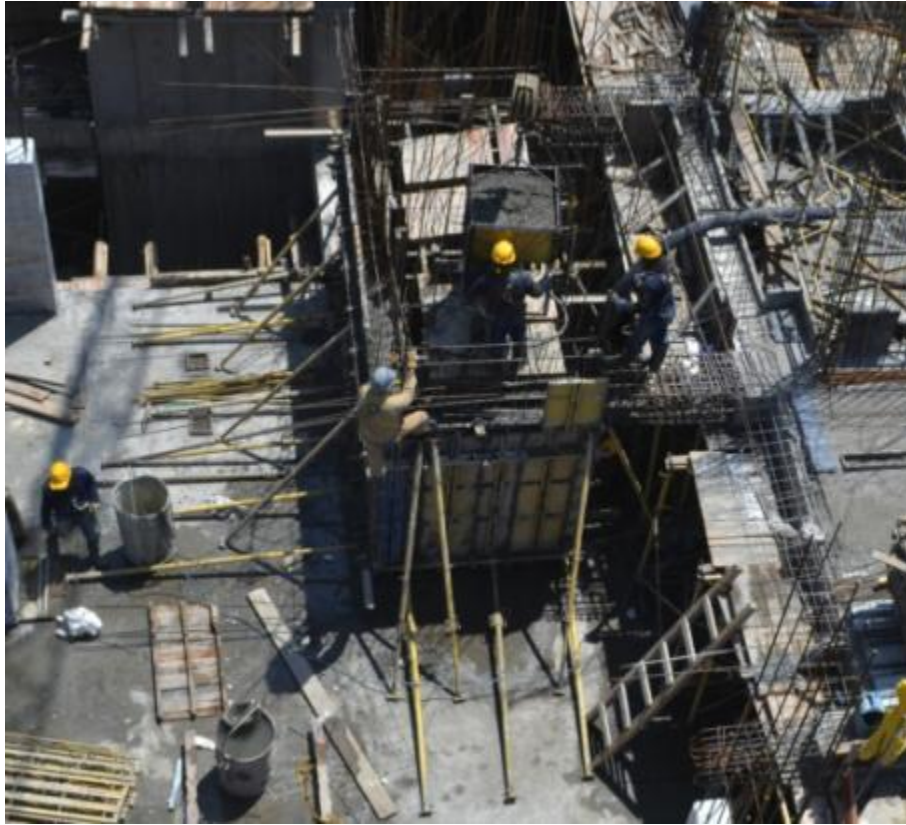
Figura 78. Fotografía 15-FEB-12. Sección de Concreto Ascensor
