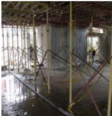
Figura 32. Armado de camas y amarre de acero. Fecha de Toma: 05-NOV-11
