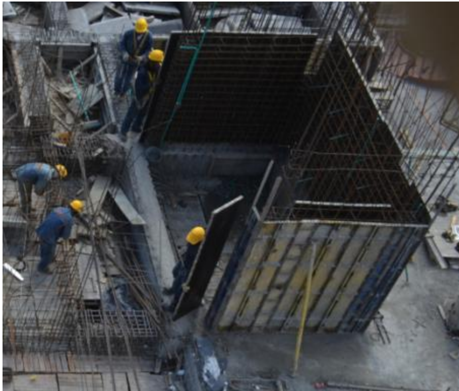
Figura 81. Fotografía 17-FEB-12. Sección de Formaleta Escalera
