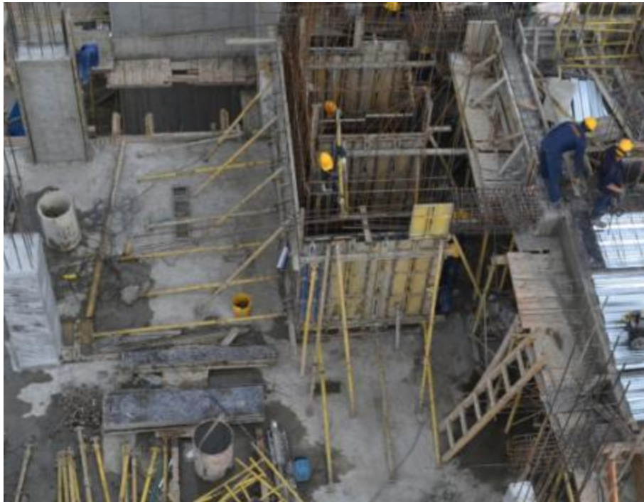
Figura 77. Fotografía 14-FEB-12. Sección de formaleta ascensor
