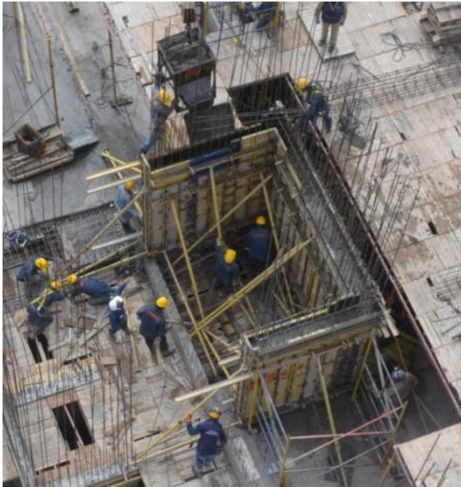
Figura 82. Fotografía 04-OCT-11. Sección de concreto escalera
