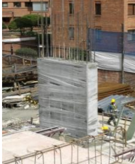
Figura 31. Fraguado de columnas. Fecha de Toma: 05-NOV-11
