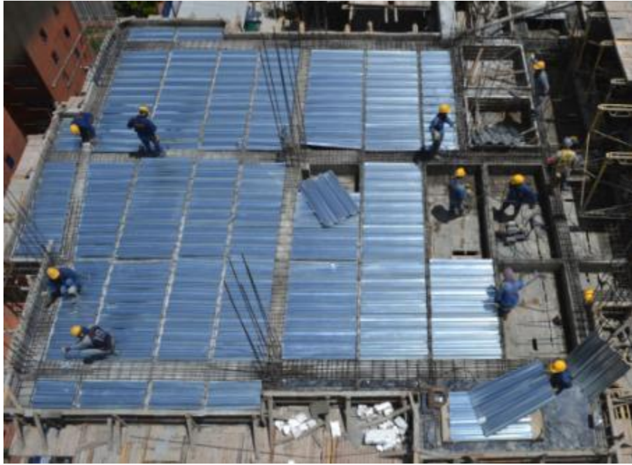
Figura 74. Fotografía 20-FEB-12. Sección de Fotografía Disposición láminas metaldeck
