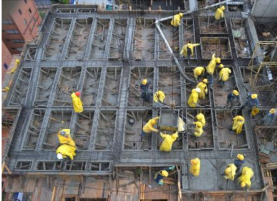
Figura 72. Fotografía 18-FEB-12. Sección de Fotografía Concreto Vigas
