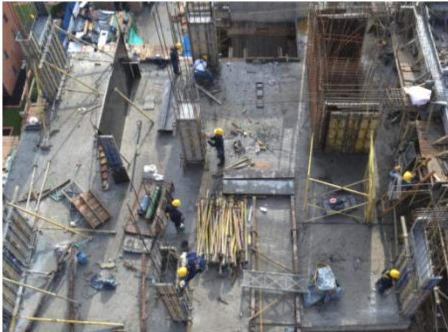
Figura 67. Fotografía 14-FEB-12. Sección de Fotografía Retiro Formaleta Columnas
