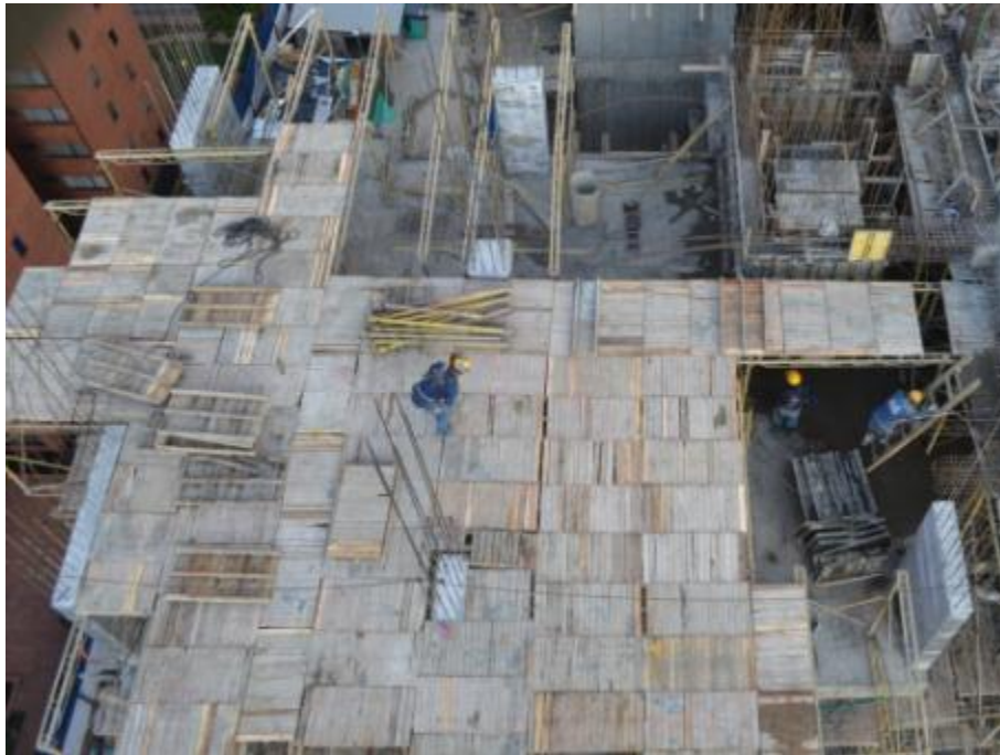
Figura 69. Fotografías 15-FEB-12. Sección de Fotografía Instalación de Camillas
