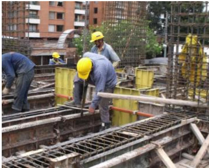
Figura 43. Corte de elementos en madera para la formaleta. Fecha de toma: 05-NOV-11
