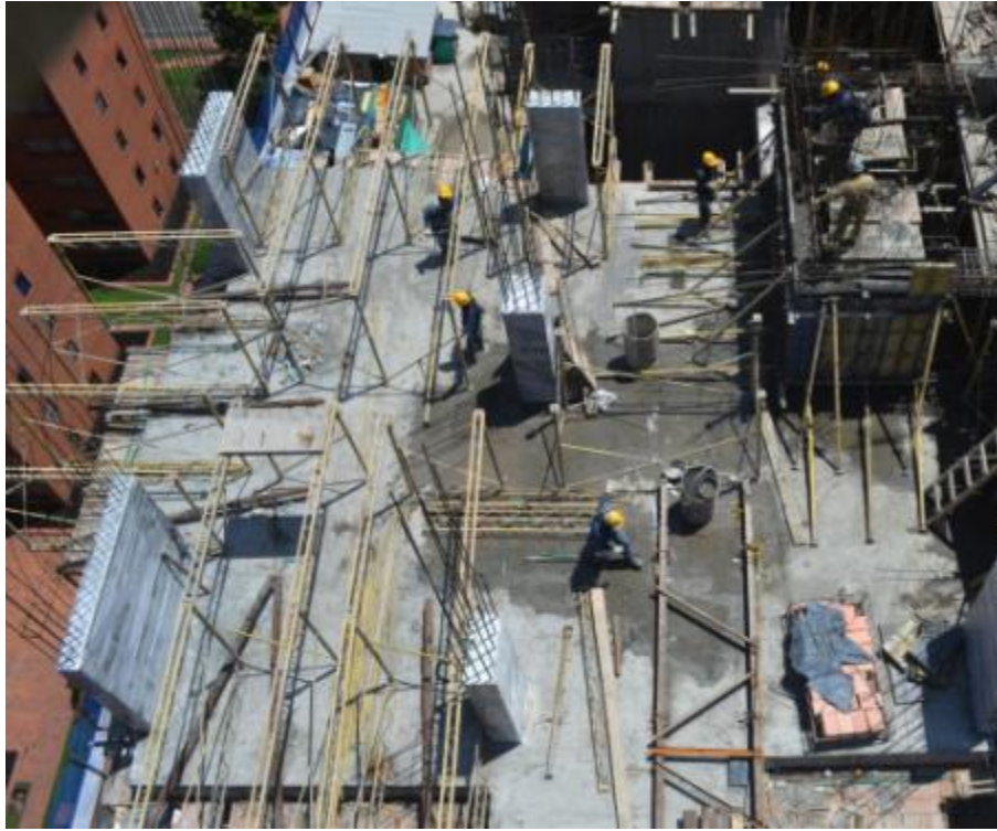
Figura 68. Fotografía 15-FEB-12. Sección de Fotografía Instalación de parales y cerchas
