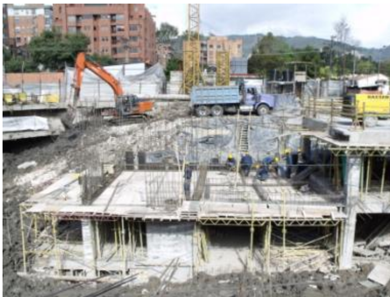
Figura 12. Vista de la obra a estudiar en su etapa inicial
