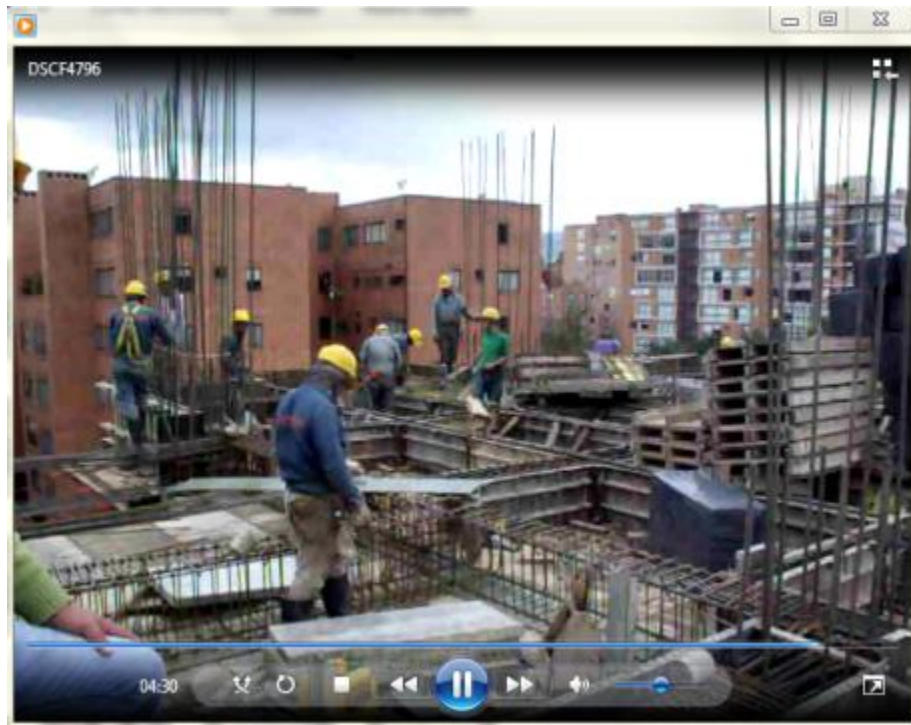
Figura 55. Video 5 minutos – Colocación formaleta vigas
