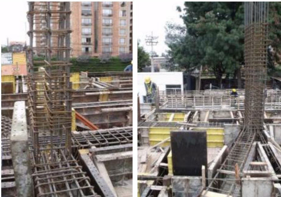
Figura 29 y 30. Construcción de columnas. Fecha de Toma: 05-NOV-11
