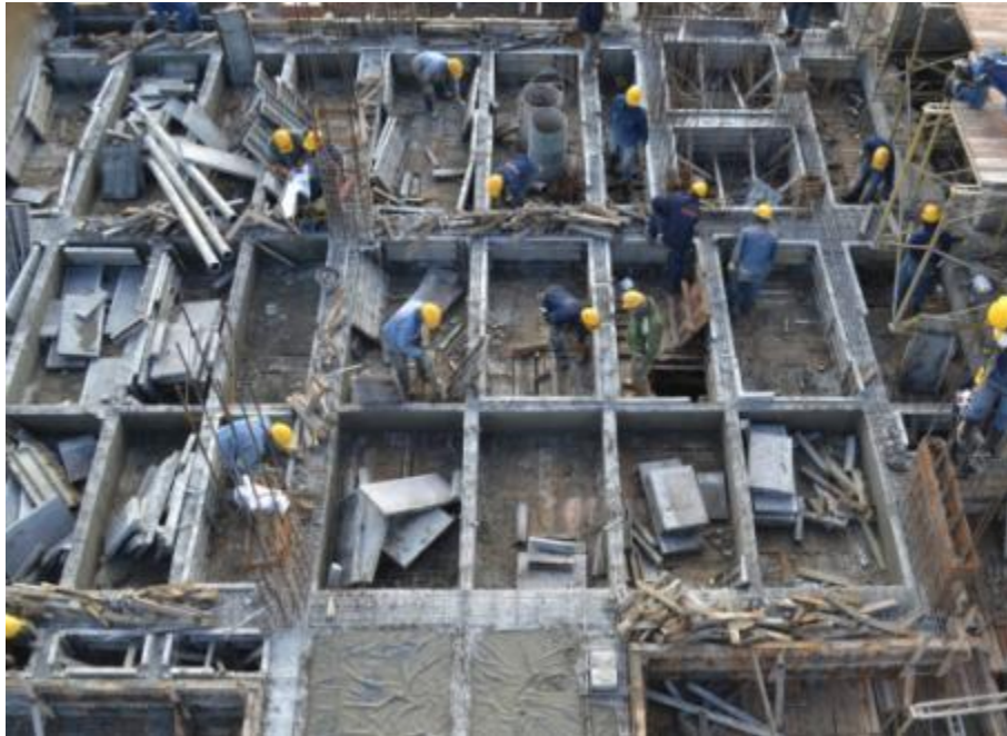
Figura 73. Fotografía 01-MAR-12. Sección de Fotografía Retiro Formaleta Vigas
