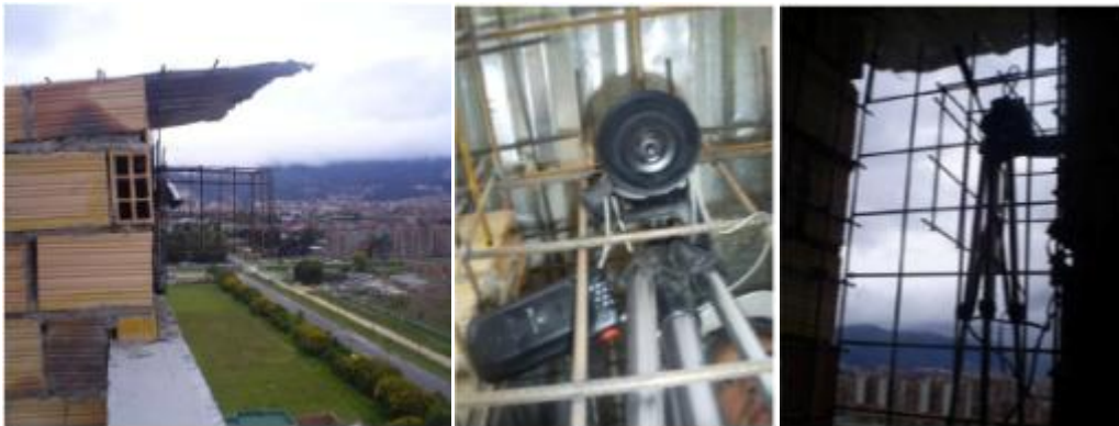
Figura 2, 3, 4. Montaje de la videocámara en la construcción. Fuente: Céspedes, 2010
