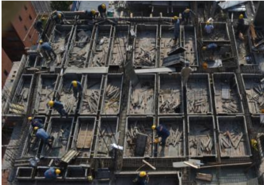
Figura 71. Fotografía 18-FEB-12. Sección de Fotografía Formaleta Vigas
