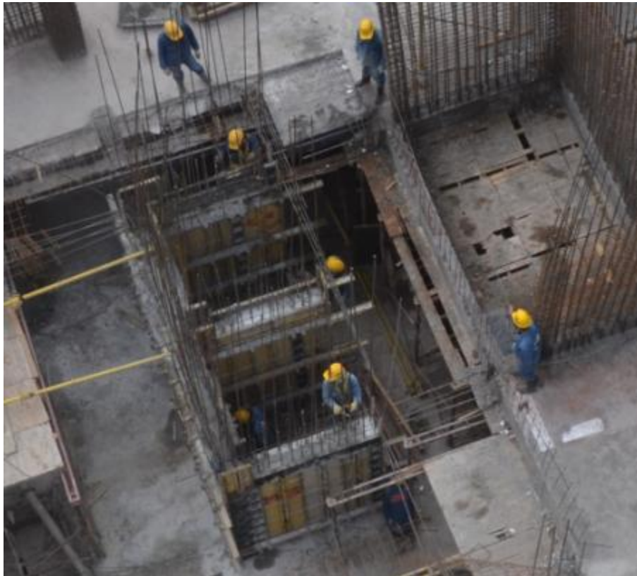
Figura 79. Fotografía 03-OCT-11. Sección de retiro formaleta ascensor
