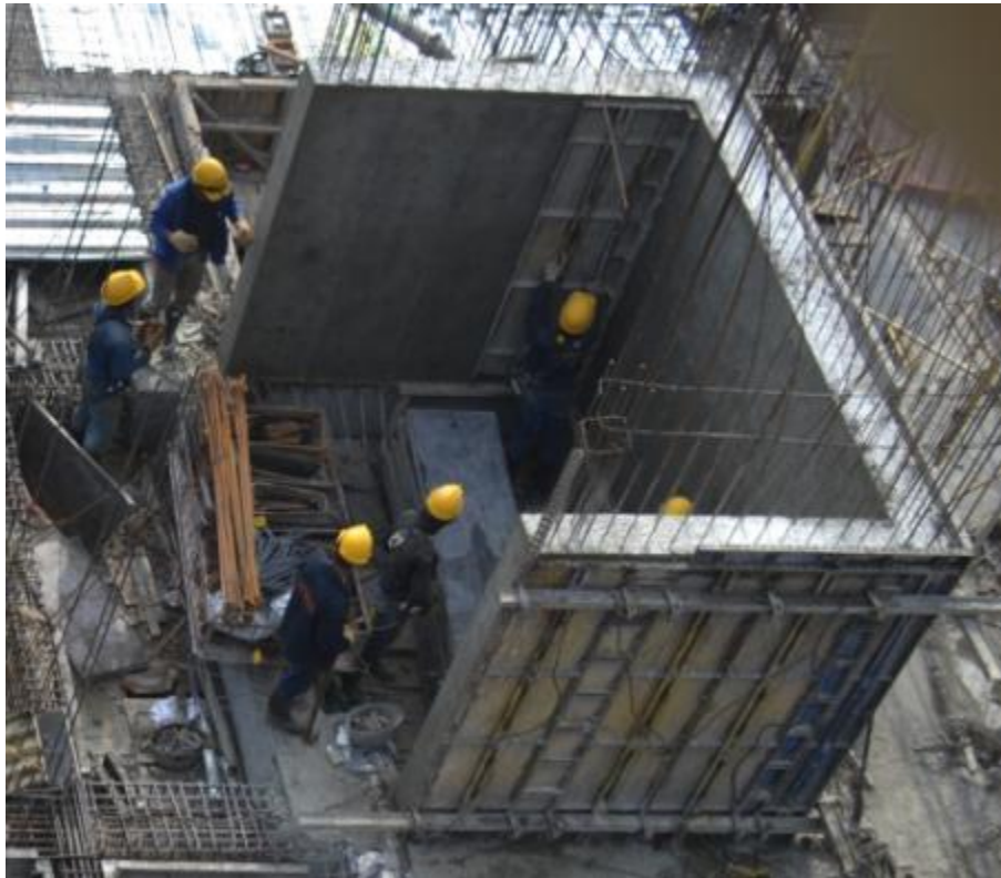
Figura 83. Fotografía 18-FEB-12. Sección de Retiro Formaleta Escalera
