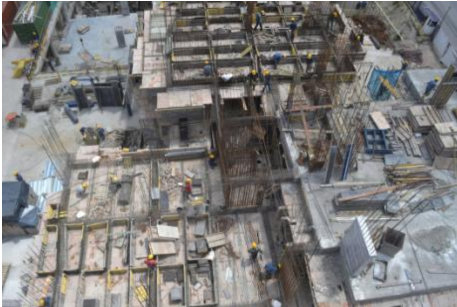
Figura 16. Vista Cámara 1. Fecha de toma: 04-NOV-2011 12:05 pm
