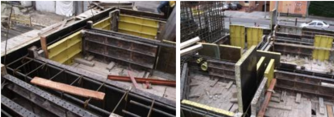
Figura 40 y 41. Formaleta para vaciado de vigas en concreto. Fecha de toma: 05-NOV-11
