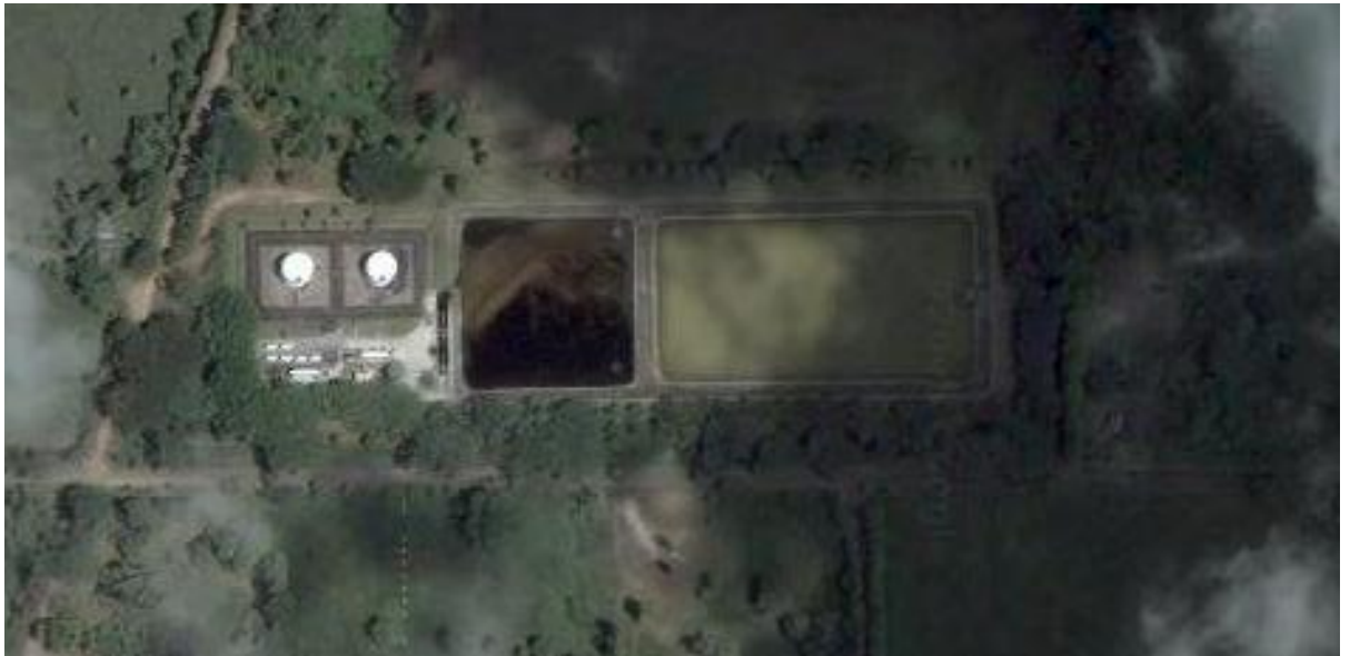
Figura 11: Estación de recolección y tratamiento No 4 del campo Casabe
