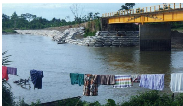
foto 10 Panorámica de la protección de la orilla de la margen izquierda del río San Pablo aguas arriba del puente en una longitud aproximada de 200m, puente San Pablo (Las Animas - Nuqui)(Muñoz, E. E., 2011)
