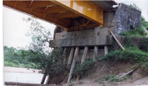
foto 4 Pilotes descubiertos del estribo del puente San Pablo localizado en el Departamento del Choco (Muñoz Edgar y Valbuena Edgar, 2006)
