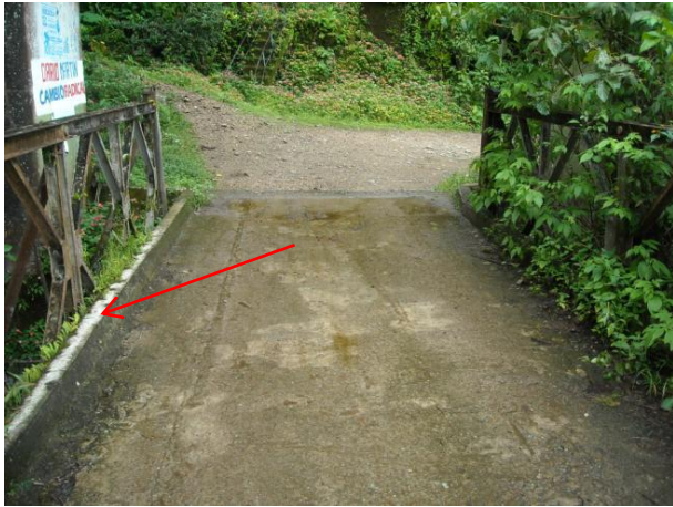
foto 43 Puente Gazaunta - Medina Se observa bordillo en concreto - Fuente propia
