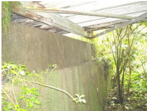
foto 41 Puente Gazaunta - Medina Se observa estribo en concreto - Fuente propia
