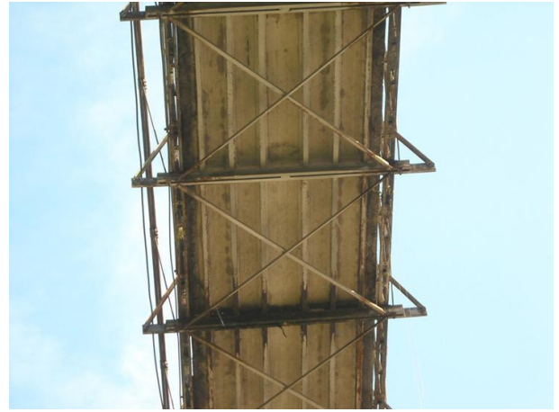
foto 44 Puente Gazaunta - Medina Se observa estructura metálica - Fuente propia
