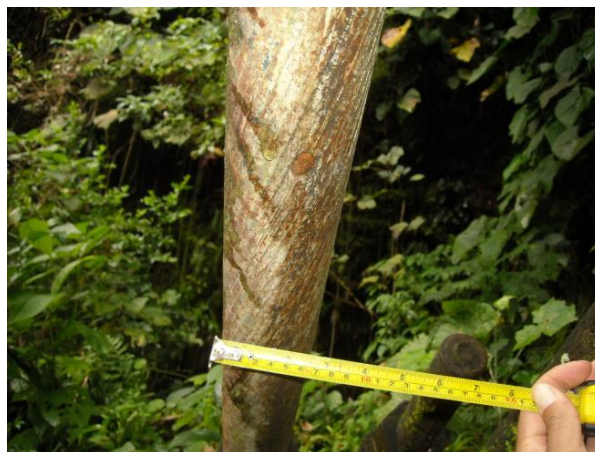
foto 46 Puente Gzaunta - Medina - Se observa corrosión de cables - Fuente propia
