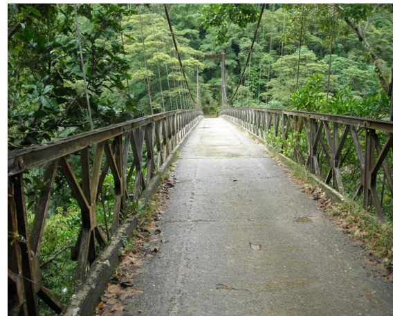
foto 42 Puente Gazaunta - Medina Se observa losa en concreto - Fuente propia
