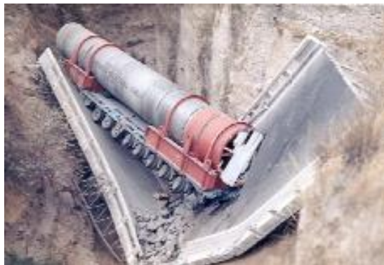
foto 35 Colapso de un puente por sobrecarga aproximada de 200(FRIAS,2010)
