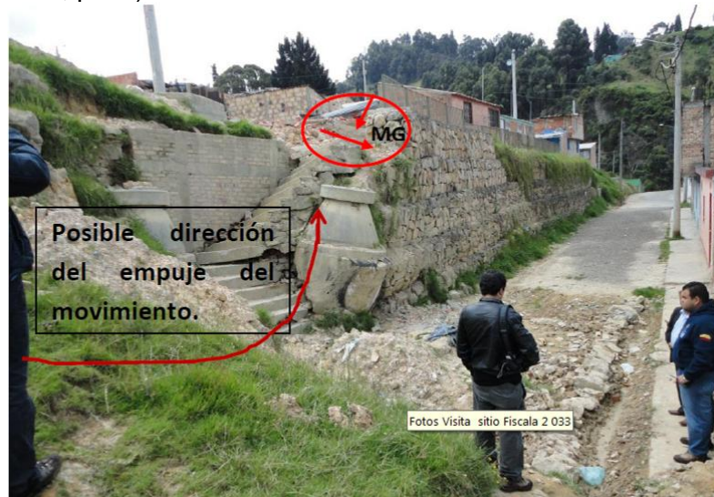
Figura 6.14 Vista detalle sitio esquina Cra 4C Este, con la Calle 79 Sur, cuyo muro en gaviones (MG) fue impactado por efectos dinámicos del movimiento (Fotografía registrada en marzo de 2011).(Consorcio Mitigación 2010, 2012, p. 58).
