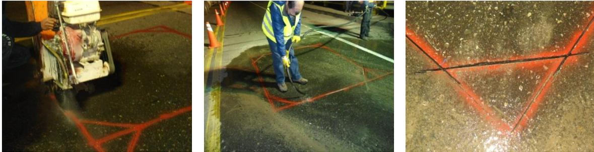
Figura 3-9 Corte y limpieza del pavimento
