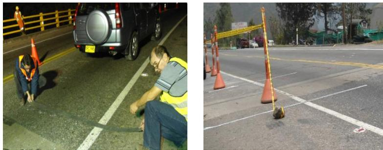
Figura 3-11 Instalación de los cables piezoeléctricos
