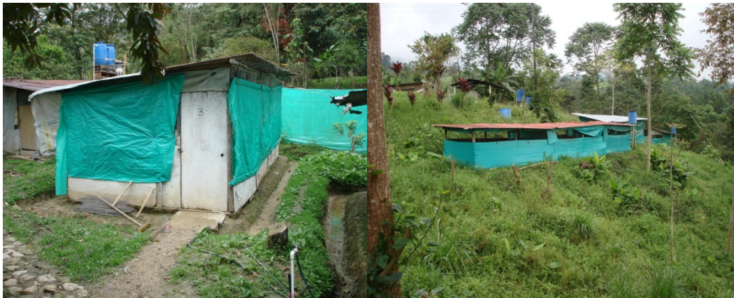
Instalaciones de productores PRESP2.
