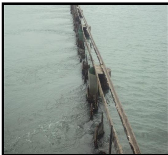
**Foto 9. Estado deteriorado de la pantalla direccional.**
