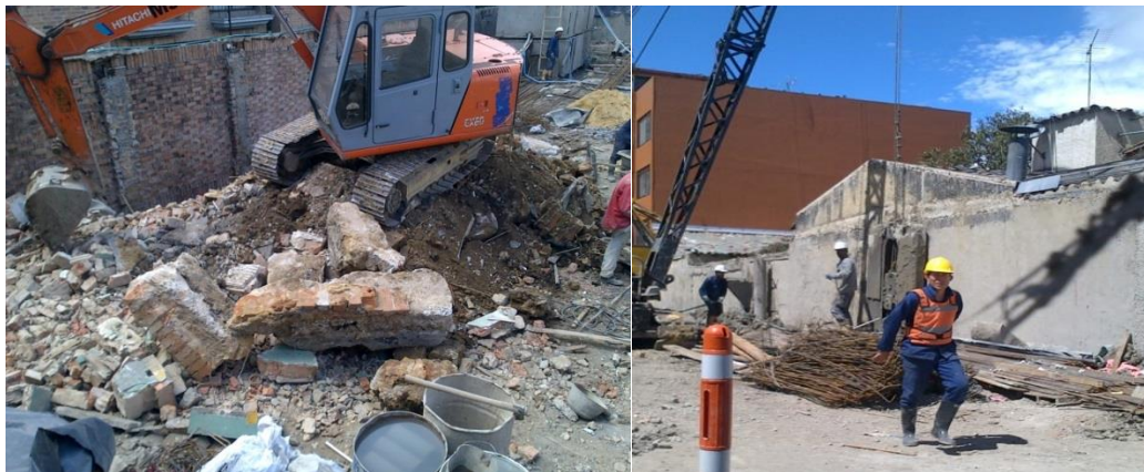
Fotografías: Demolición Edificación. CII 97 No 13 - 55 Fecha: 06/2013 y Pilotaje Edificación. CII 97 No 13 - 55 Fecha: 08/2013
