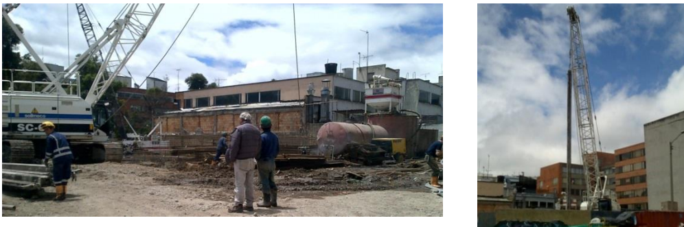
Fotografía: Pilotaje CII 97 con 13 Fecha 08/2013
