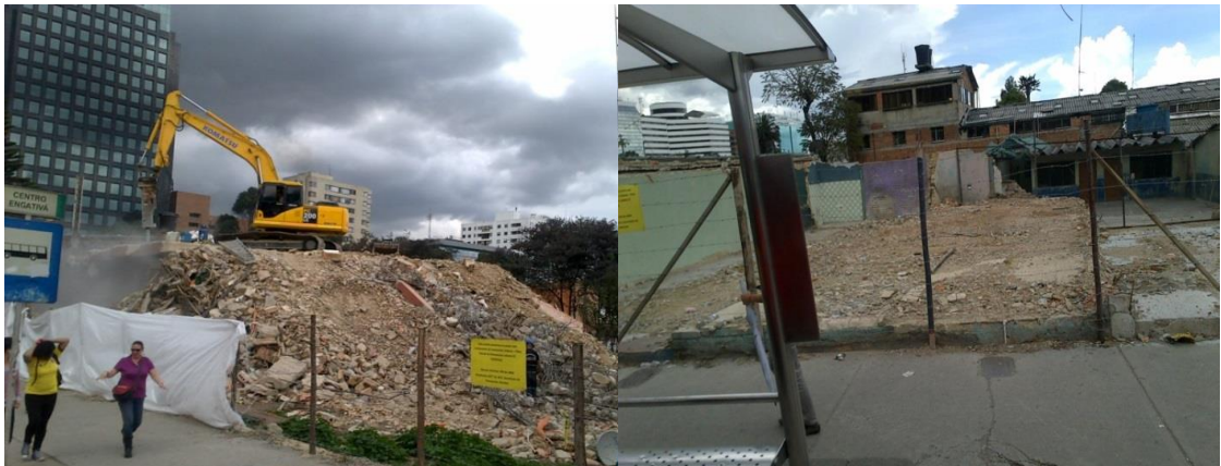
Fotografía: Demolición generando emisiones. Cra 7 con 100 Fecha: 08/2013
