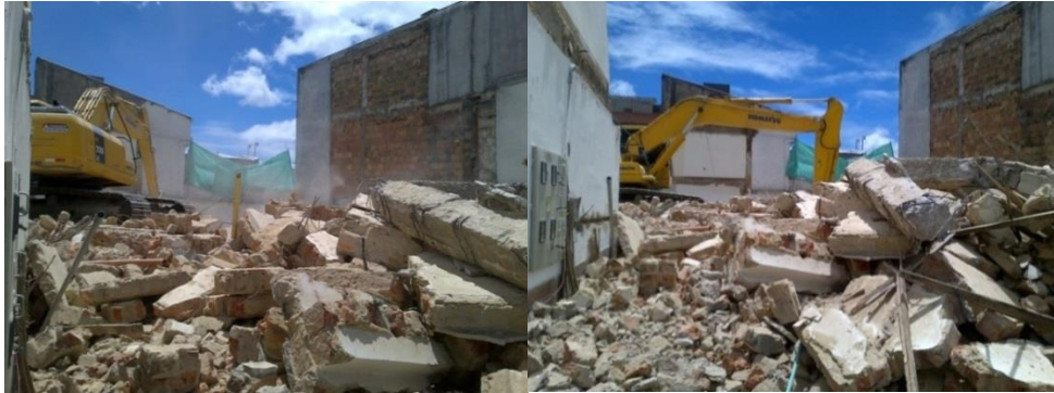
Fotografía: Demolición Edificación. Autopista Norte Cll 94 Costado Occidente Fecha: 07/2013
