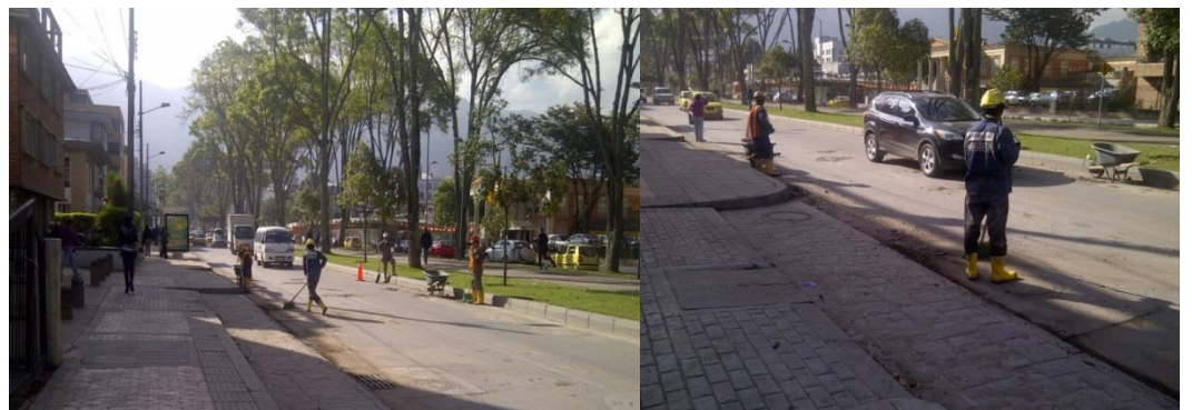
Fotografía: Realizando actividades de limpieza y barrido de residuos de las obras de construcción CII 92 con 16 Fecha: 09/2013
