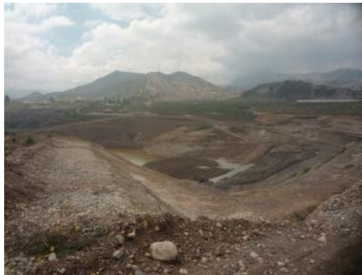
Figura 4. Sitio de disposición final autorizado en el Distrito Capital: Cemex La Fiscala
