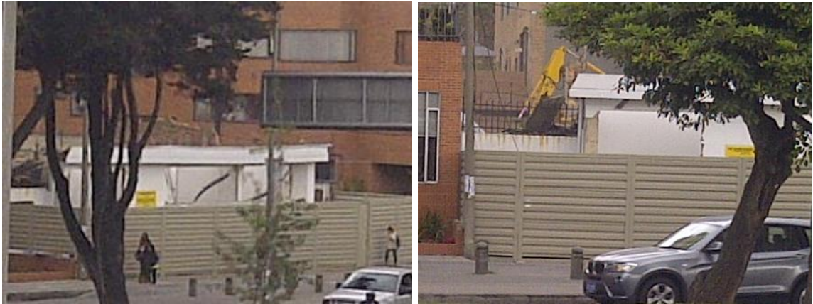
Fotografías: Actividades de demolición. Autopista Norte CII 91 Costado Oriental Fecha: 08/2013
