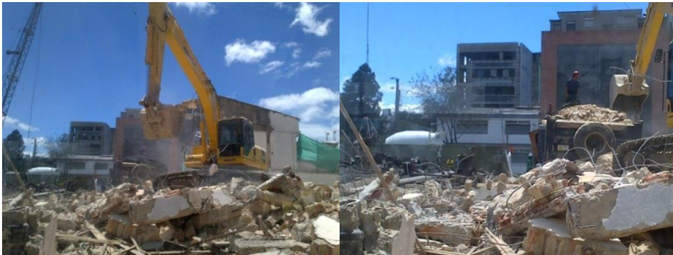
Fotografía: Demolición Edificación. Autopista Norte Cll 94 Costado Occidente Fecha: 07/2013
