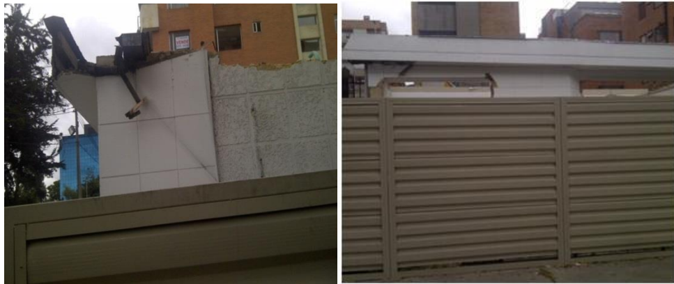
Fotografía: Actividades de demolición. Autopista Norte CII 91 Costado Oriental Fecha: 08/2013
