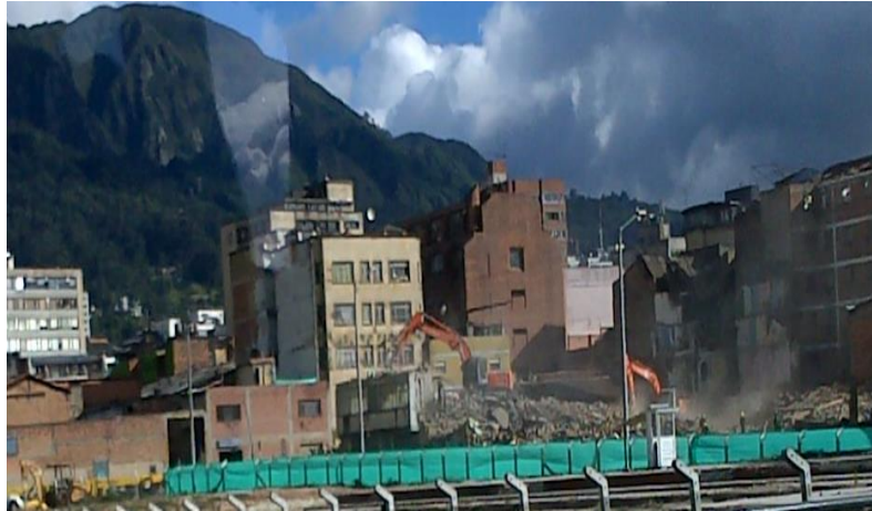
Fotografía: Emisiones generadas por la demolición. AV Caracas con CII 26. Fecha: 09/2013
