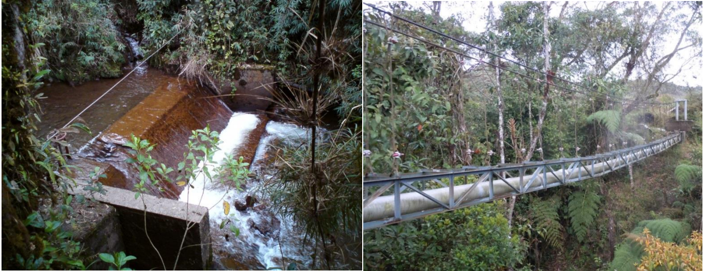
Fotos 17 y 18. Bocatoma (izquierda) y paso a nivel tubería Distrito de riego Asoucoacha (derecha). (Fotos Jerson González Umaña).
