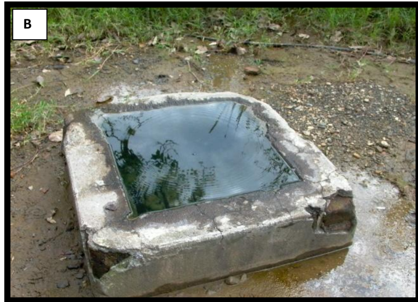
Figura 7. A) Imagen del pozo del manantial LC después de descargar el agua contenida. B) Imagen del pozo del manantial LC completamente lleno.
