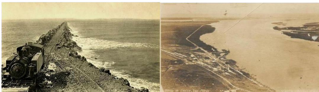
Fotografías N° 7 y 8. (Izquierda) Vista de Bocas de Ceniza comienzo década de los treinta. (Derecha) Tajamares en Bocas de Ceniza.
