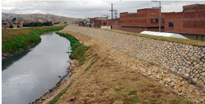
Fotografía 6 Realce de diques
