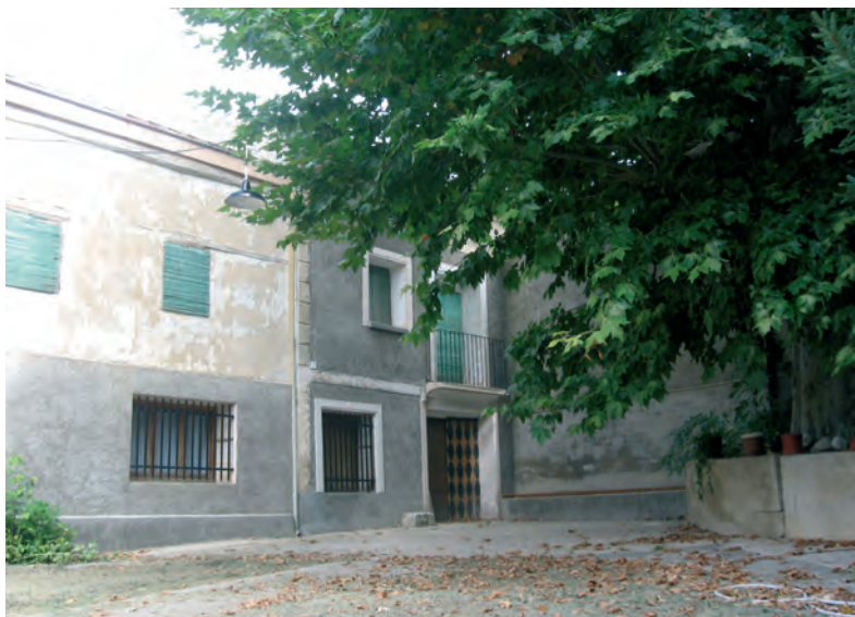
Figura 9.5. Antigua posada de Luco de Jiloca.
